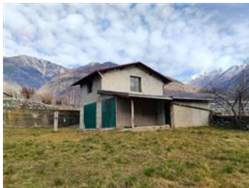
F.TO 1_MAGAZZINO AGRICOLO
