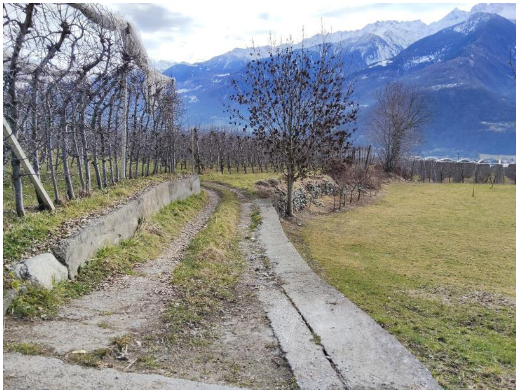
FOTO 9 – accesso al frutteto foglio 16 particella 351
