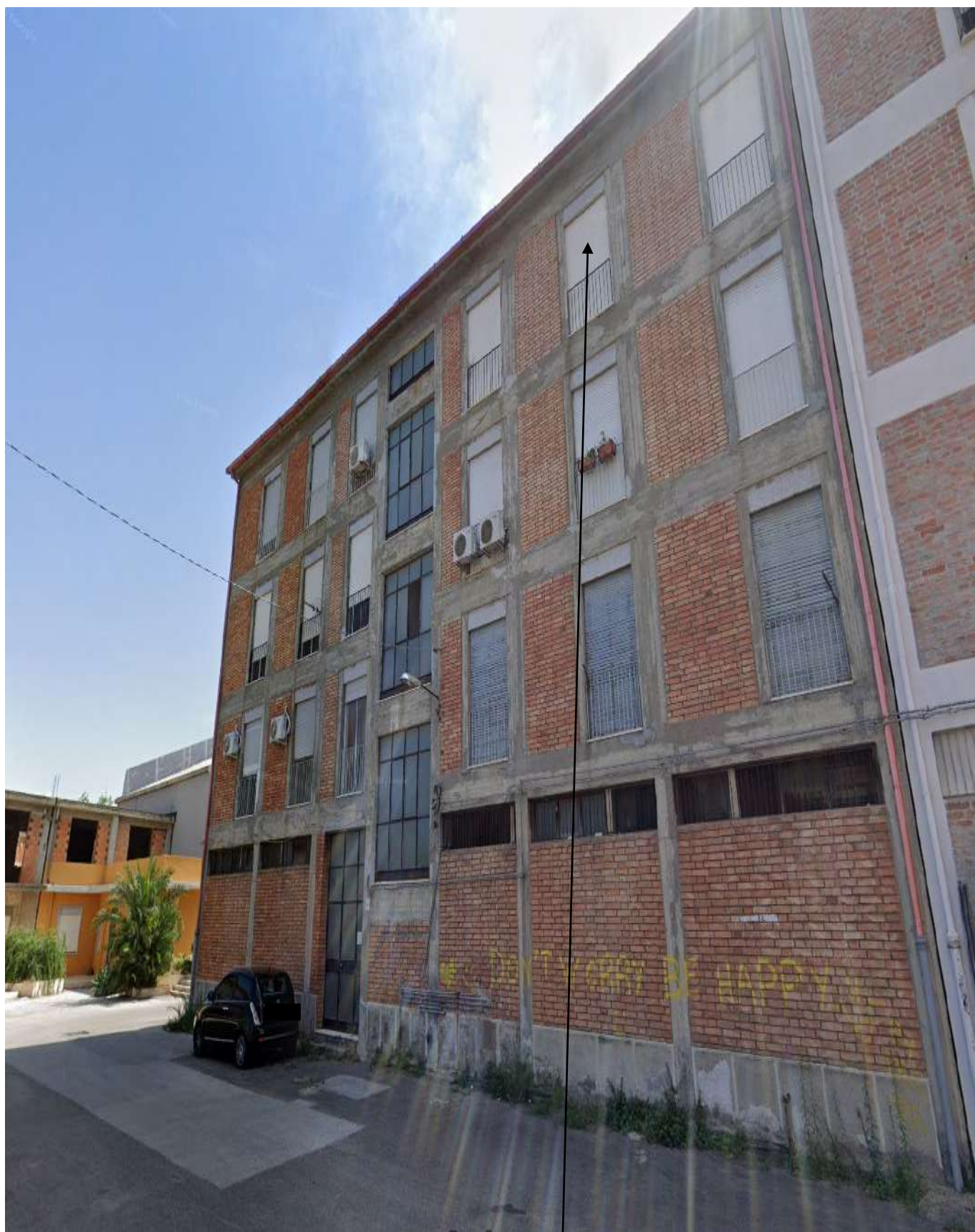
Retro prospetto Palazzina “6”
