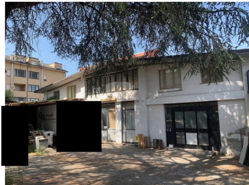
FOTO ESTERNE – EDIFICIO DI RIFERIMENTO
