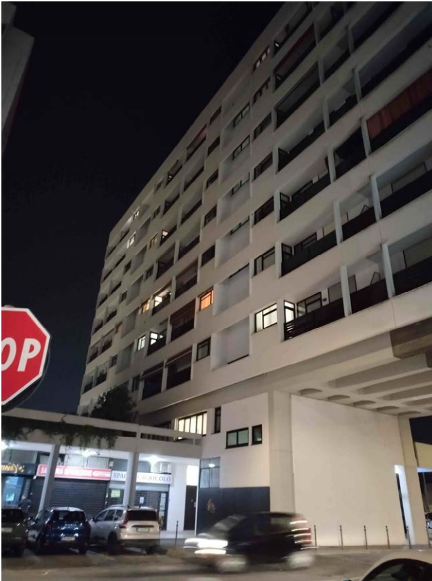
Foto 1. Prospetto su Largo Risorgimento
