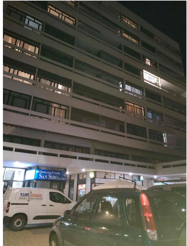
Foto 2. Prospetto su Largo Risorgimento
