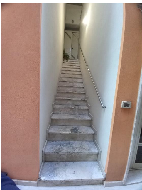
Fig. 23 – Scala di accesso
