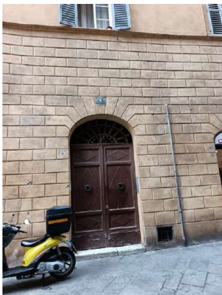
Portone d'ingresso all'immobile da via di Diacceto n.c. 22
