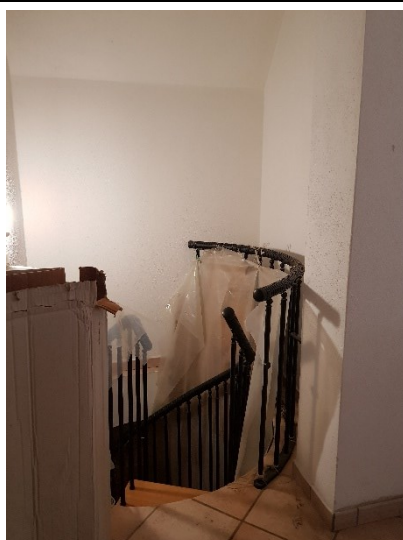
Foto 36 Accesso Sottotetto P2
