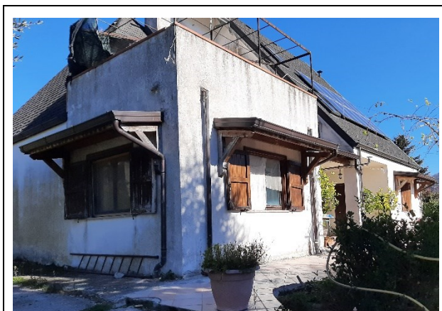
Foto 5 Particolare pensiline di protezione aperture
