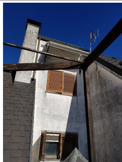
Foto 34 Particolare vano scala
