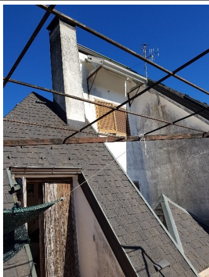
Foto 32 Particolare Tetti vista da terrazzo P1
