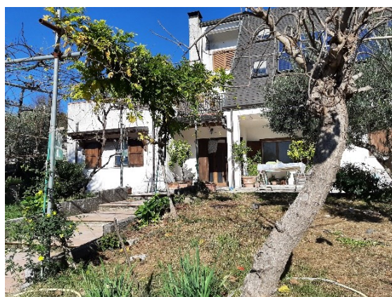
Foto 2 Vista esterna lato sud
