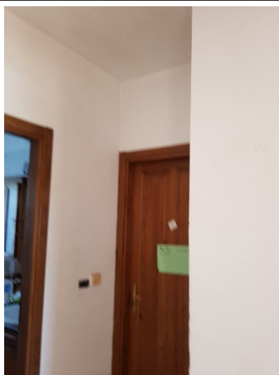
Foto 15 Disimpegno PT- partic. porta collegamento UI sub 2
