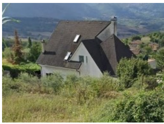
Foto 4 Vista esterna lato nord
