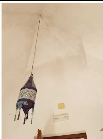
Foto 30 Particolare soffitto Camera C2 –P1
