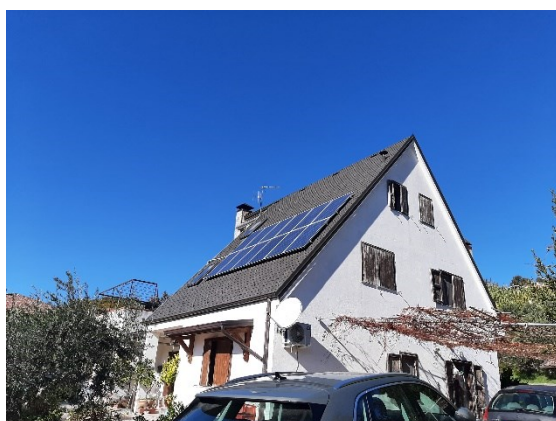
Foto 3 Vista esterna lato est
