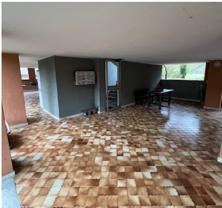
Portico comune di accesso al piano terra
