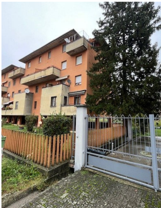
Vista prospetto sud
