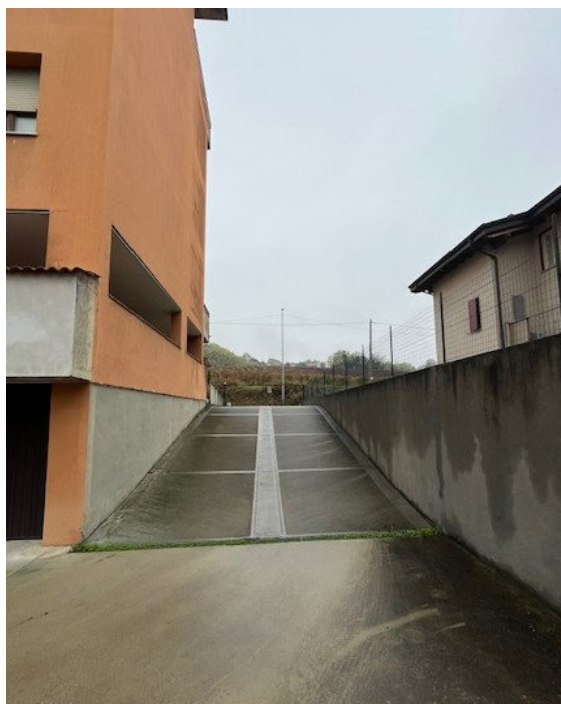
Vista rampa carraia
