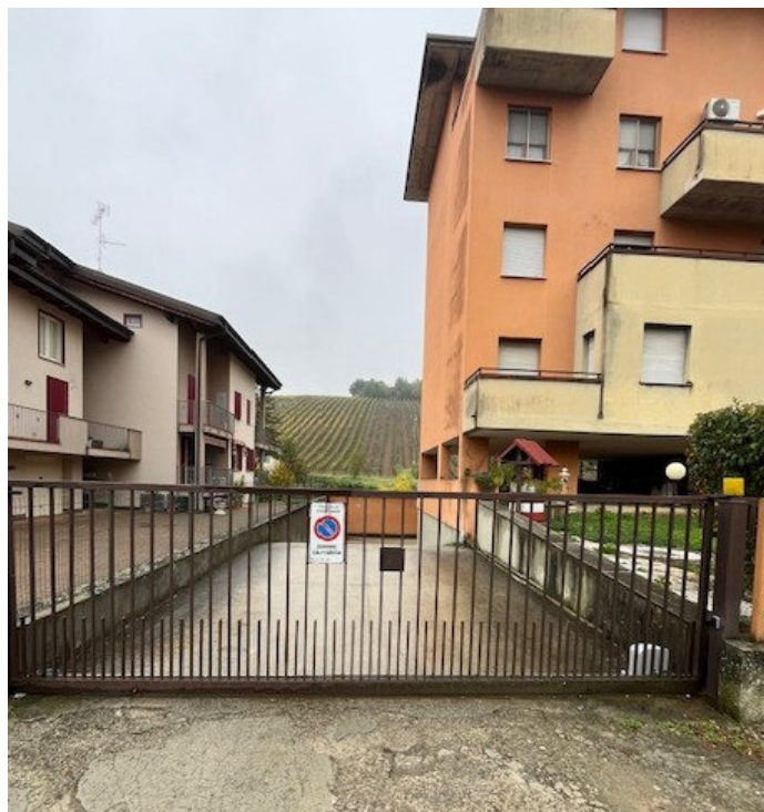
Vista ingresso carraio da via Vigorelli
