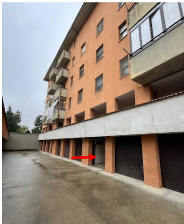
Vista corte comune con ingresso al box
