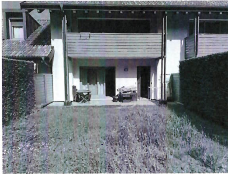
Foto panoramica fronte Sud - mn. 462 sub 2 (appartamento p.T)
