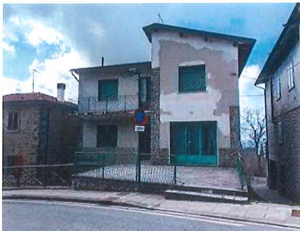
Prospetto frontale su Via Roma
