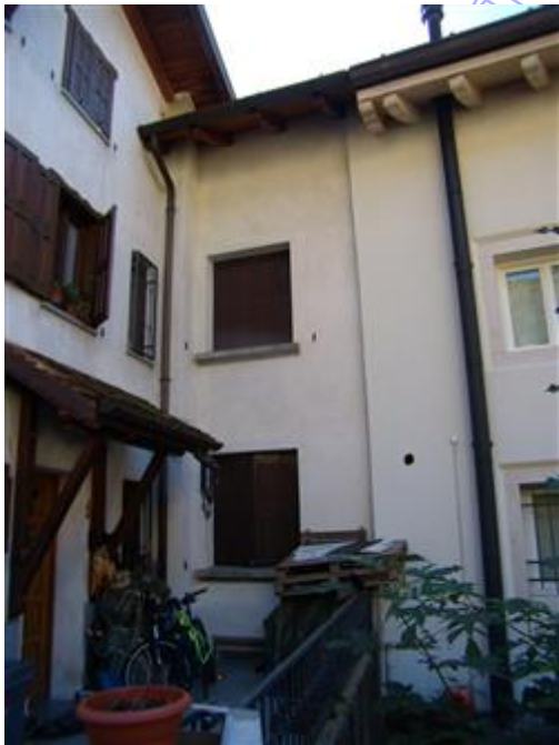
Fronte nord, con le due aperture su fondo di terzi (servitù attiva di veduta)
