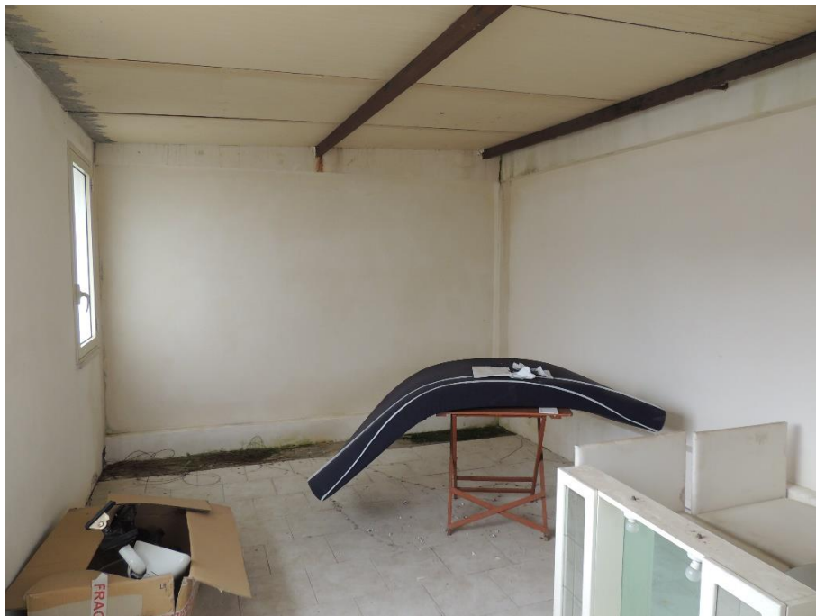
Interno locale uffici
