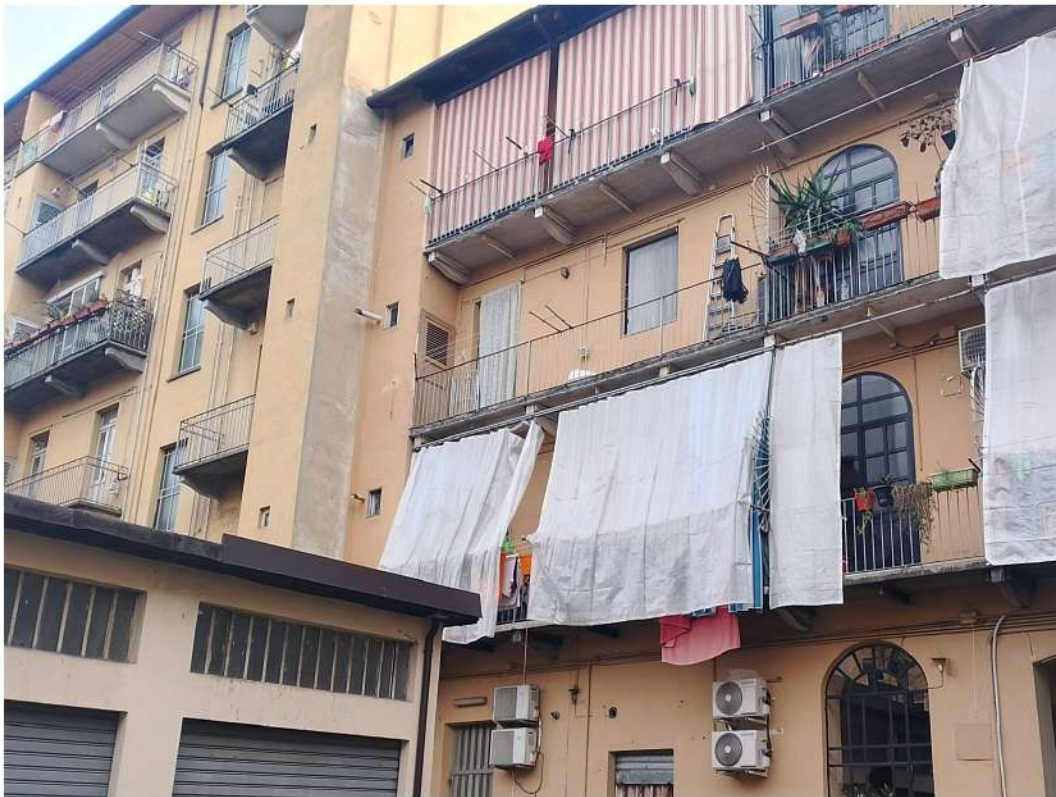
Foto n. 3: prospetto lato cortile
