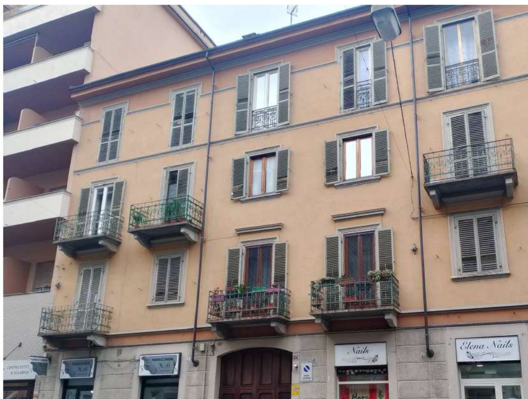
Foto n. 1: Torino, via Frejus n. 56
