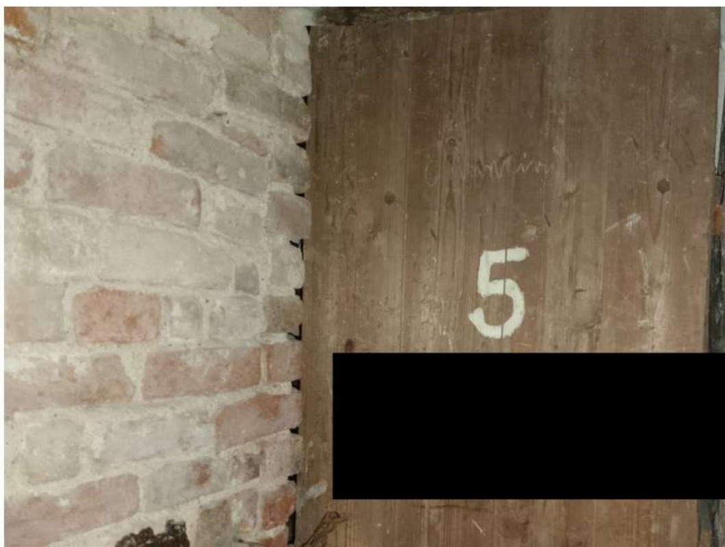
Foto n. 12: accesso alla cantina n. 5
