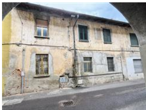
Prospetto su via G. Zaffaroni.
