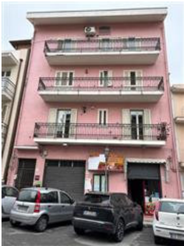
1 - prospetto principale sulla via Giuseppe Garibaldi (intero fabbricato)
