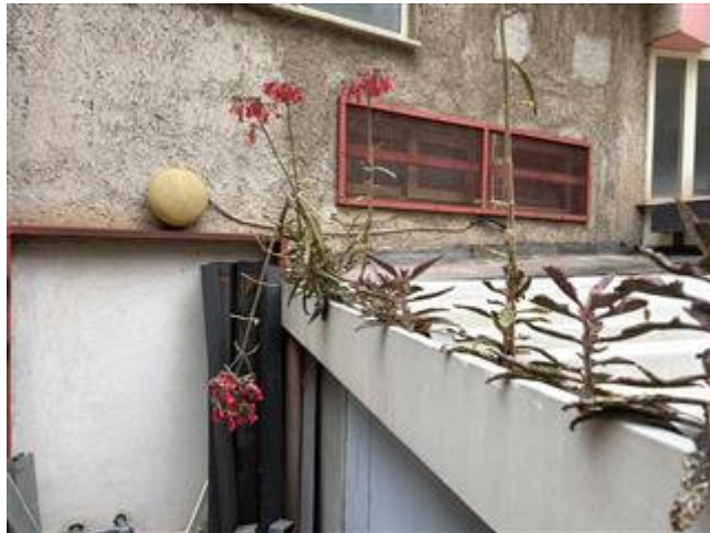
2 - parte del prospetto retrostante del bene oggetto di pignoramento adibito a deposito con cortile adiacente (corpo retrostante)
