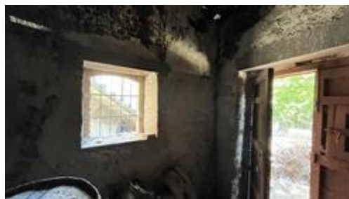
Vista interna (verso porta di ingresso)
