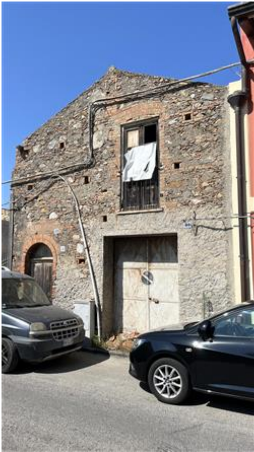
Fronte principale del fabbricato sulla via Palombaro
