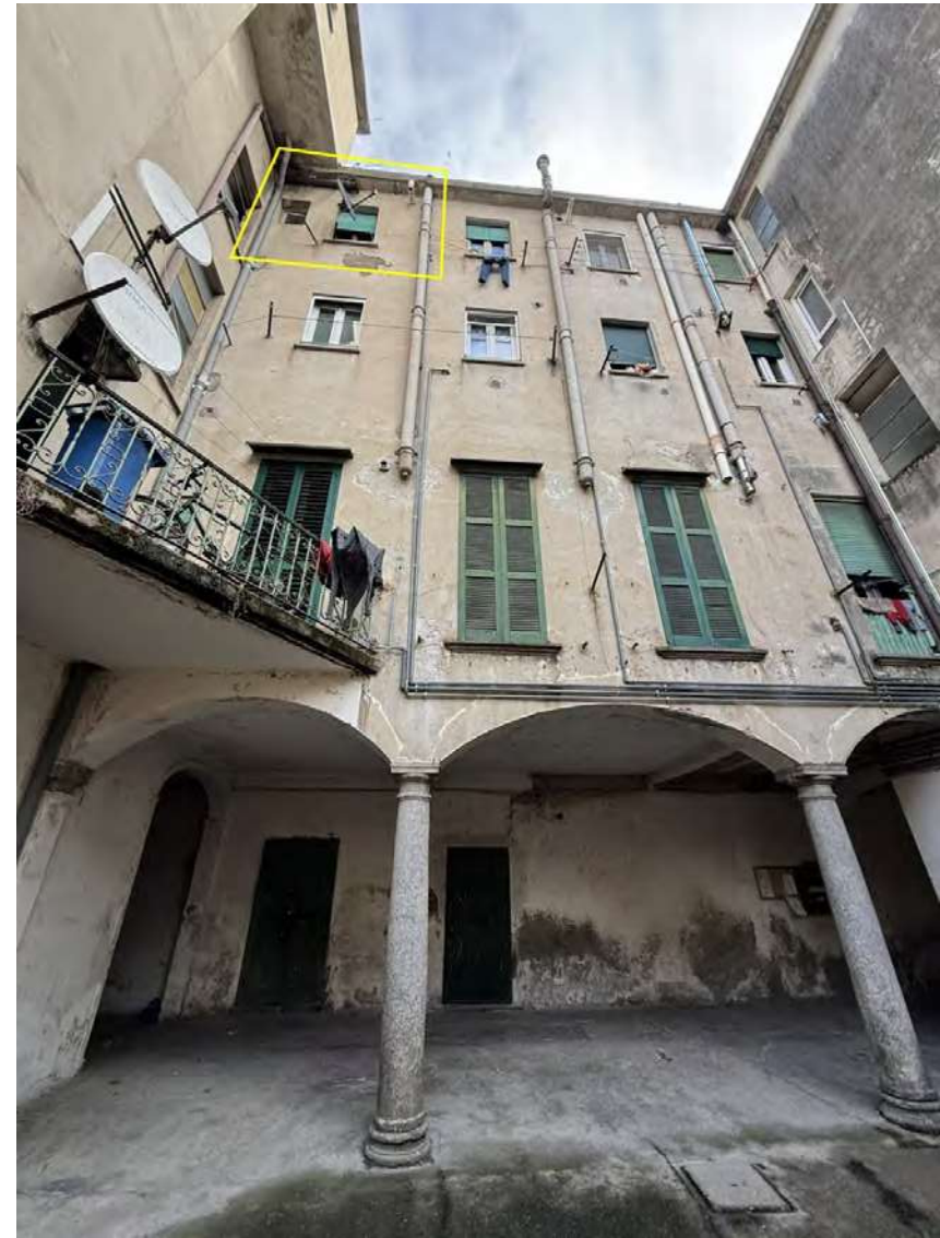
FOTOGRAFIA n. 2: Vista fronti sud-ovest della palazzina dal cortile comune.
