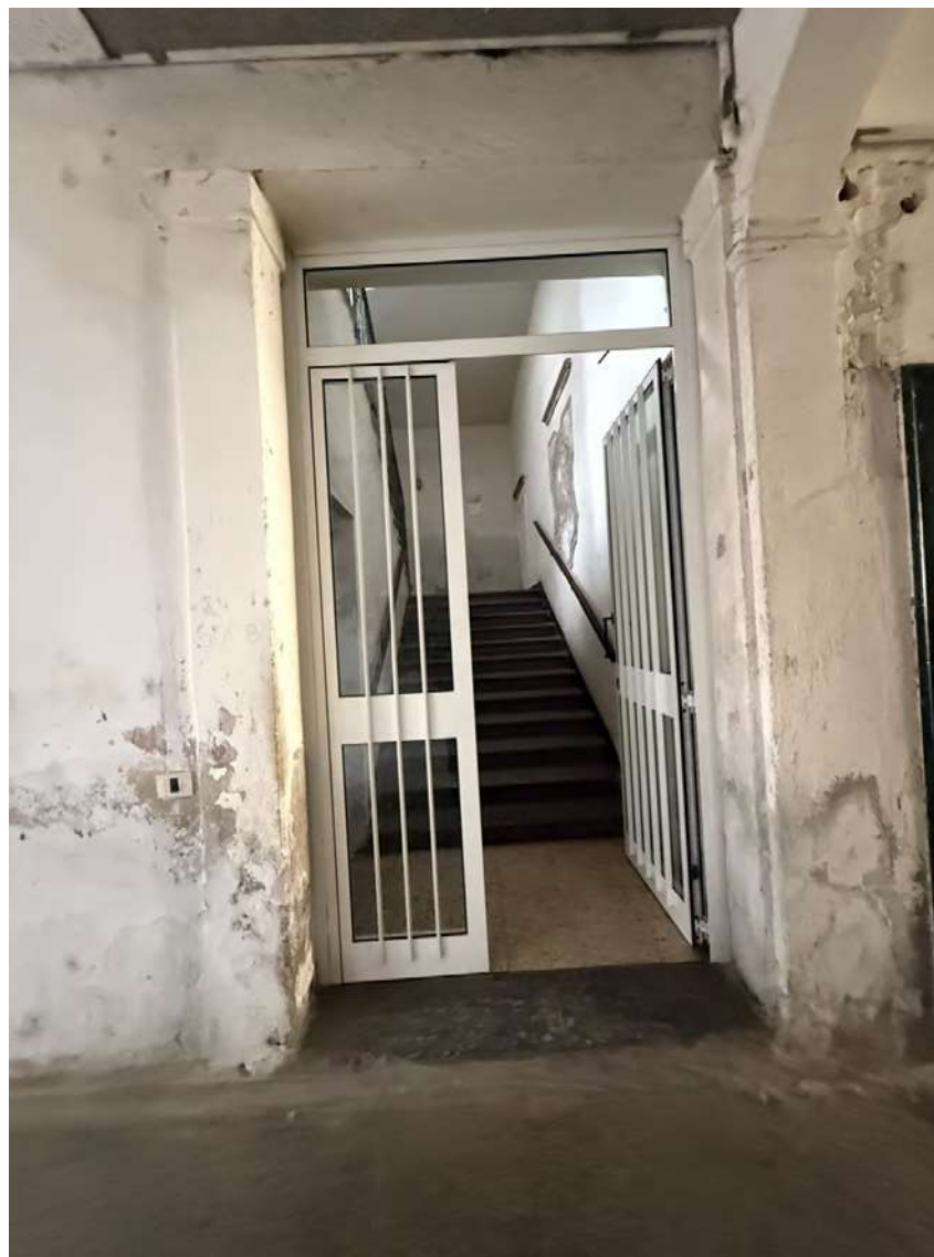
FOTOGRAFIA n. 4: Vista vano scala comune
