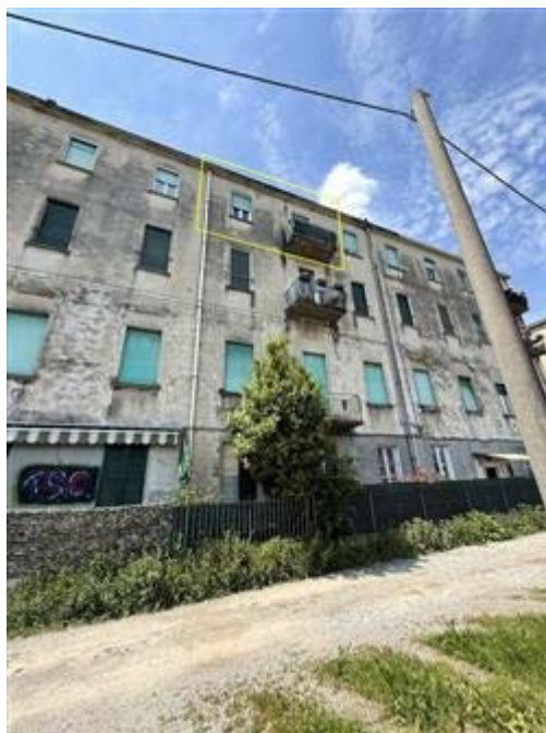
Vista esterna fronte nord-est su Lago di Olginate
