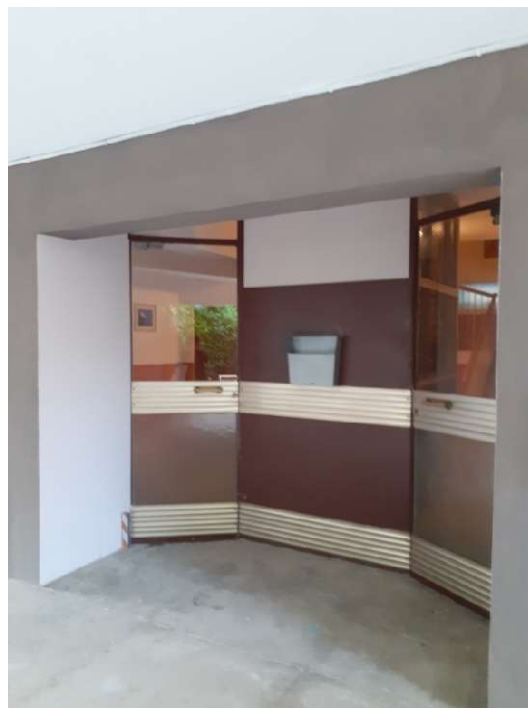
n. 3 ingresso condominiale
