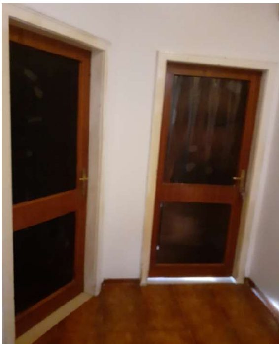
n. 10 ingressi a due stanze non accessibili
