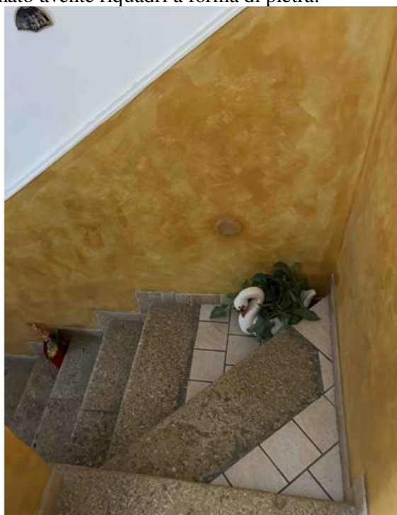
Foto n° 20 – Altra foto scattata alla scala interna che consente l’accesso al primo piano. La pedata della scala è in pietra mentre il pianerottolo intermedio è realizzato in gres porcellanato. Le pareti sono intonacate e tinteggiate con due tecniche e colorazioni differenti, spatolato fino all’altezza di 1,00 metro ed idropittura nella parte superiore.
