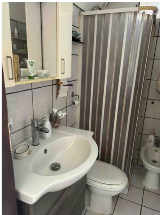
Foto n° 44 – Foto scattata al bagno del primo piano. La pavimentazione ed il rivestimento è stato realizzato con piastrelle in maiolica delle dimensioni di cm 20x20 cm.
