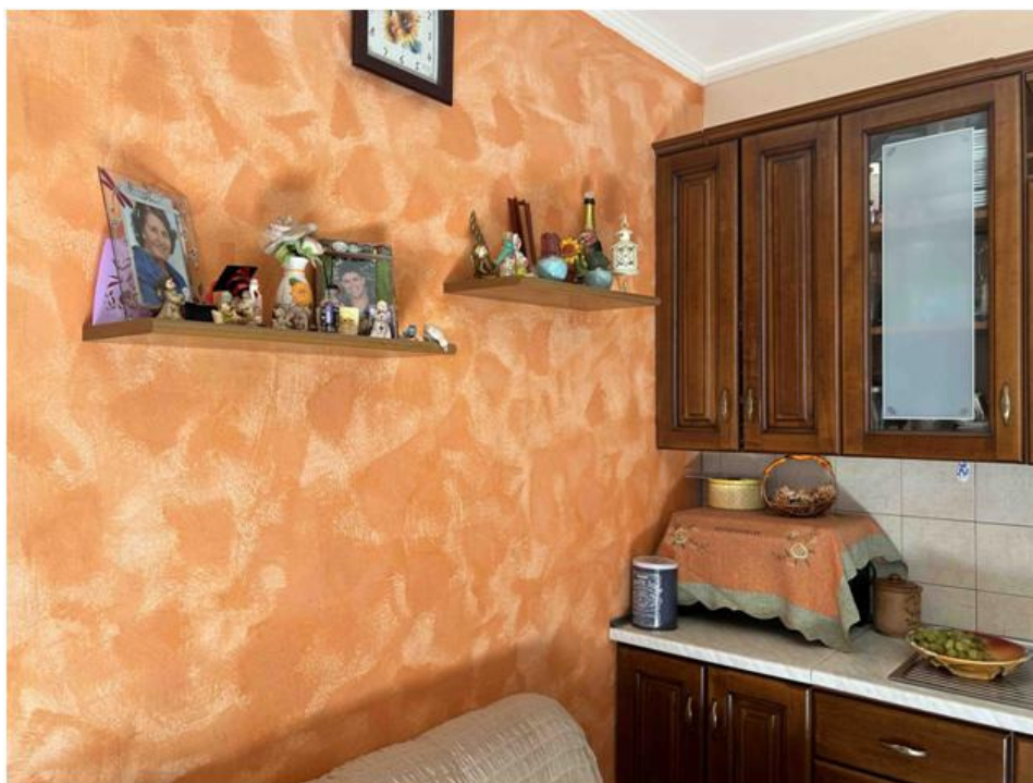
Foto n° 25 – Foto scattata nel vano cucina. Tutte le pareti sono intonacate, tinteggiate e rifinite con la tecnica dello spatolato. La parete della cucina è rivestita con piastrelle delle dimensioni di cm. 20x20 cm mentre la parte soprastante i mobili è tinteggiate con idropittura.
