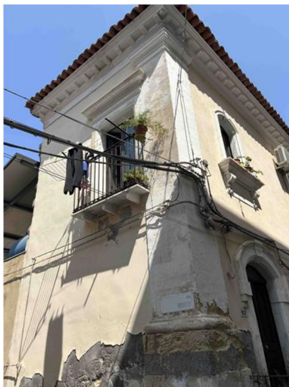
Foto n° 4 – Altra vista del prospetto di via Appennino. L'edificio presenta un piano terra, un primo piano ed un secondo piano e vistose macchie di umidità di risalita in corrispondenza del cantonale del piano terra.
