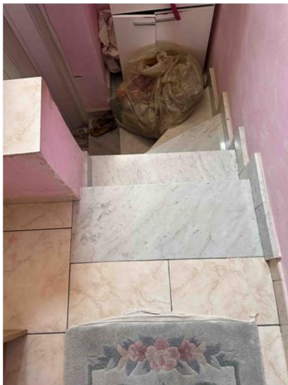
Foto n° 51 – Altra foto scattata nella scala che collega il primo piano con il secondo piano. Le pedate e le alzate della scala sono tutte rivestite con marmo.
