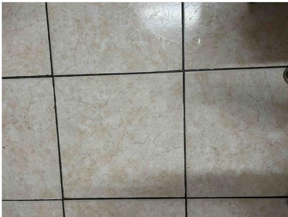
Foto n° 15 – Foto scattata alla pavimentazione in gres porcellanato del piano terra. Discrete le condizioni generali.
