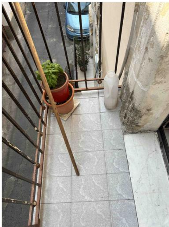
Foto n° 33 – Foto scattata al ballatoio esterno che consente l'affaccio su via Principessa di Piemonte. La ringhiera è in ferro pieno in buone condizioni mentre la pavimentazione è in gres porcellanato antiscivolo.
