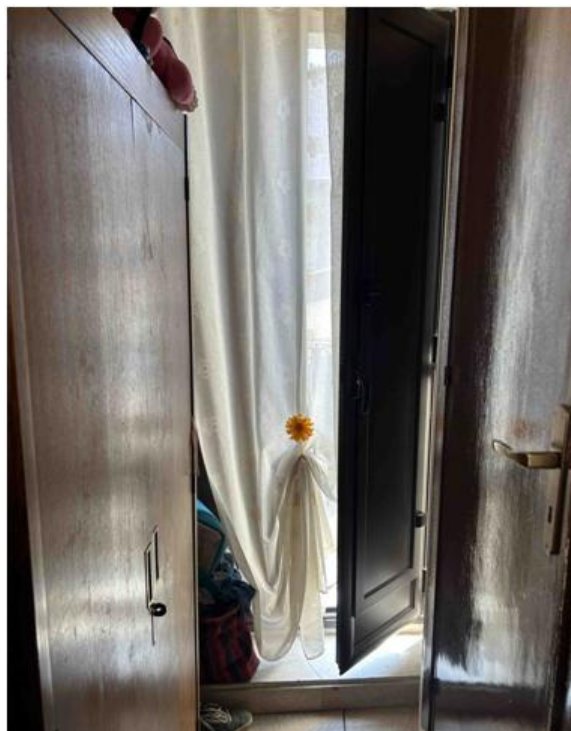
Foto n° 49 – Foto scattata all’infisso in alluminio pre-verniciato, dotato di scurette interne in alluminio. Sulla destra è visibile la porta che consente di accedere alla scala che conduce al secondo piano.
