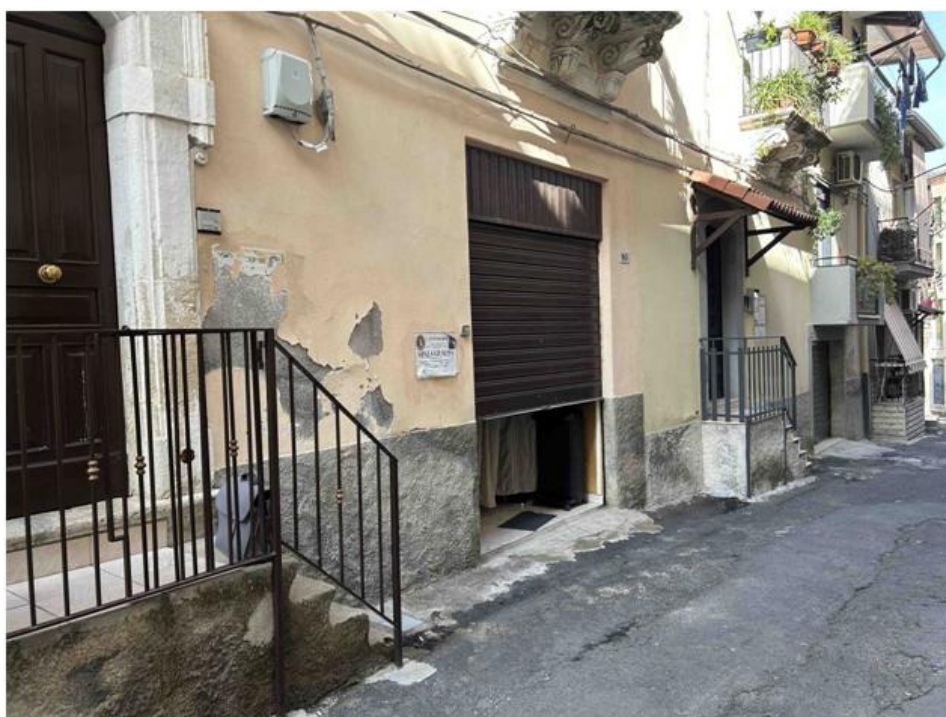
Foto n° 8 – Foto scattata alla saracinesca di ingresso ubicata in via Principessa di Piemonte n. 60 che consente l'accesso al piano terra del fabbricato.
