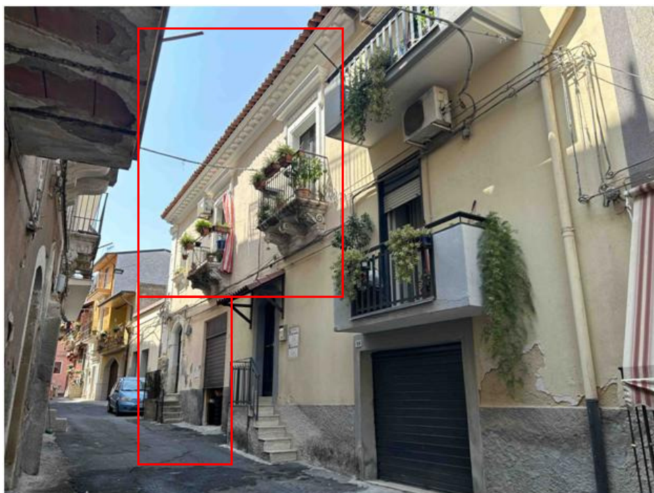
Foto n° 6 – Altra vista del prospetto principale su via Principessa di Piemonte. Con i riquadri in rosso si sono indicate le porzioni di fabbricato al piano terra ed al primo piano di proprietà degli esecutari.
