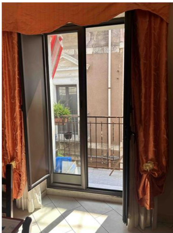
Foto n° 32 – Foto scattata all'infisso in alluminio pre-verniciato, dotato di scurette interne in alluminio.
