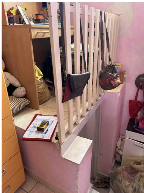
Foto n° 56 – Altra foto scattata alle pareti del secondo piano e/o della scala ed alla porzione di solaio che è stato realizzato sopra il vano scala che risulta pavimentato e tinteggiato.
