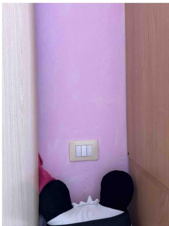
Foto n° 58 – Foto scattata all'interruttore del corpo illuminante posto nel secondo piano. L'impianto è sottotraccia e risulta a norma con le vigenti norme in materia.
