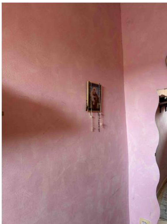
Foto n° 53 – Le pareti del secondo piano sono tutte intonacate, tinteggiate e rifinite con la tecnica dello spatolato.
