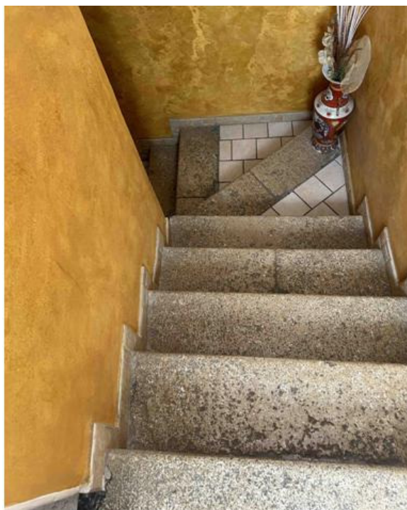
Foto n° 21 – Altra foto scattata alla scala interna che consente l'accesso al primo piano. La pedata della scala è in pietra mentre il pianerottolo intermedio è realizzato in gres porcellanato. Ottime le condizioni generali.
