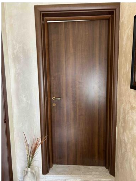
Foto n° 24 – Foto scattata nel pianerottolo di arrivo al primo piano. Le pareti sono tutte intonacate, tinteggiate e rifinite con la tecnica dello spatolato. La porta di ingresso al vano cucina è in legno e di buona manifattura. Ottime le condizioni.
