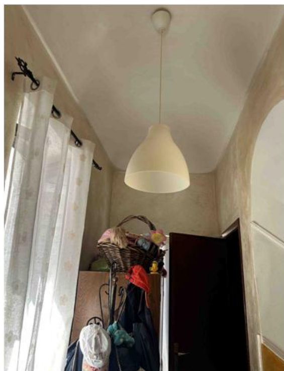
Foto n° 48 – Foto scattata nel pianerottolo del primo piano che consente l'accesso alle due camere del primo piano, al bagno ed alla scala di accesso al secondo piano. E' visibile un corpo illuminante con tubazione sottotraccia. Le pareti sono tutte intonacate, tinteggiate e rifinite con la tecnica dello spatolato.
