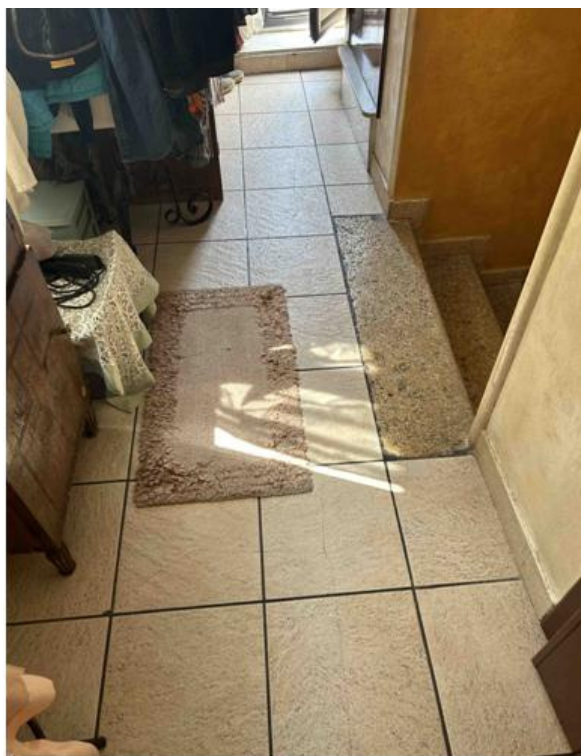
Foto n° 23 – Foto scattata al pianerottolo di arrivo al primo piano. La pavimentazione è in gres porcellanato. Ottime le condizioni.
