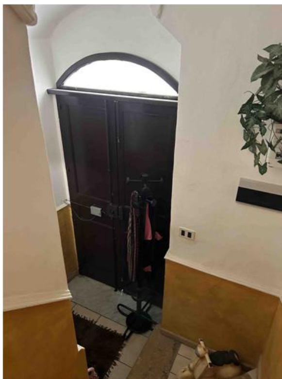
Foto n° 17 – Foto scattata al piano terra del fabbricato. Le pareti del vano scala sono intonacate e tinteggiate con due tecniche e colorazioni differenti, spatolato fino all'altezza di 1,00 metro ed idropittura nella parte superiore. Ottime le condizioni.
