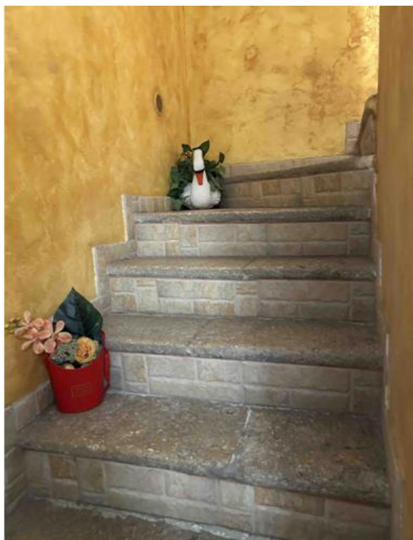
Foto n° 19 – Foto scattata alla scala interna che consente l’accesso al primo piano. La pedata della scala è in pietra mentre l’alzata è realizzata con mattoni in gres porcellanato avente riquadri a forma di pietra.
