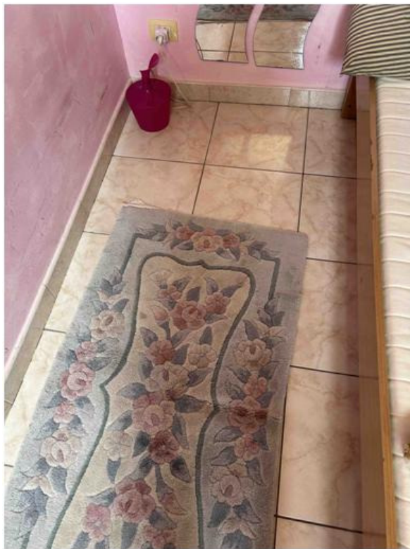
Foto n° 52 – Foto scattata alla pavimentazione in gres porcellanato collocata nel vano del secondo piano. Ottime le condizioni.
