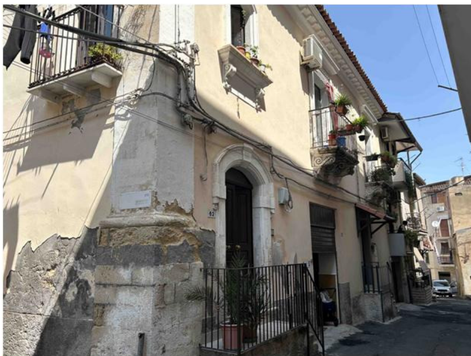
Foto n° 3 – Prospetto principale su via Principessa di Piemonte. L'edificio, il cui ingresso è rialzato rispetto alla sede stradale, presenta un piano terra, un primo piano ed un secondo piano. La facciata al piano terra su via Appennino presenta delle macchie di umidità di risalita in corrispondenza del cantonale.
