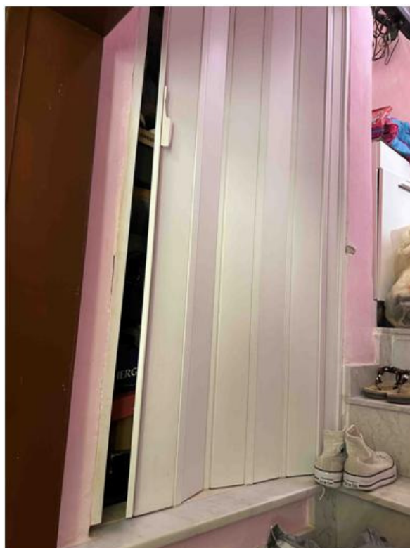
Foto n° 50 – Foto scattata nella scala che collega il primo piano con il secondo piano. E’ visibile un ripostiglio laterale dotato di porta a soffietto.
