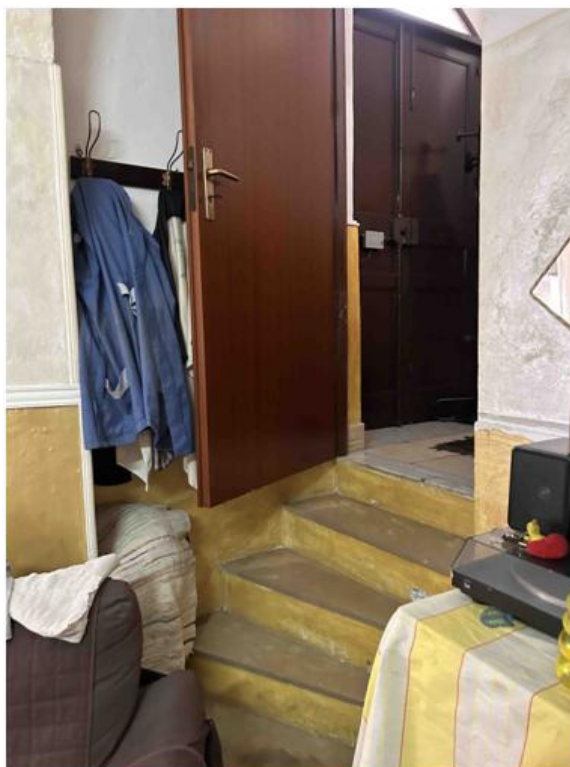
Foto n° 10 – Foto scattata alla porta interna che consente l'accesso dal piano terra al vano scala (piano rialzato) accessibile dal numero civico 62.
