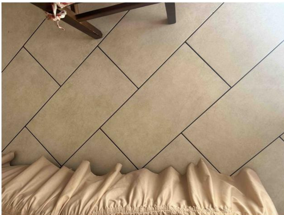
Foto n° 28 – Foto scattata alla pavimentazione del vano cucina realizzata in gres porcellanato. Ottime le condizioni.
