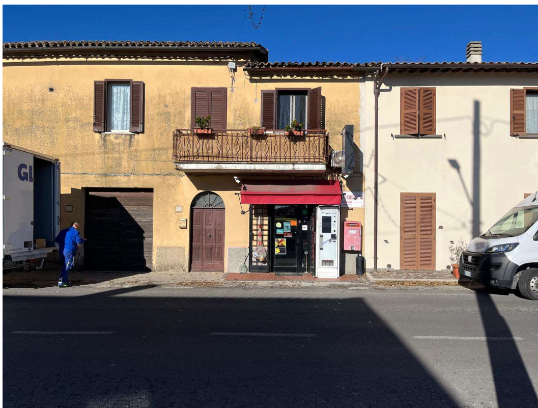
FOTO N° 1 – ESTERNO FABBRICATO – ACCESSO
