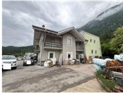
Vista su prospetto est e piazzale esterno (zona sud)
