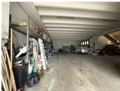
magazzino - piano terra
