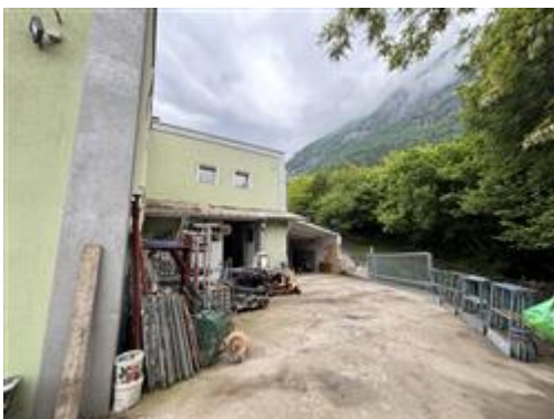
Vista su prospetto est e piazzale esterno (zona nord)
