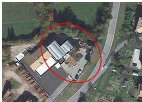
Vista Aerea - contesto zonale - in evidenza immobile oggetto di valutazione - immagini 2025 - scala a vista
