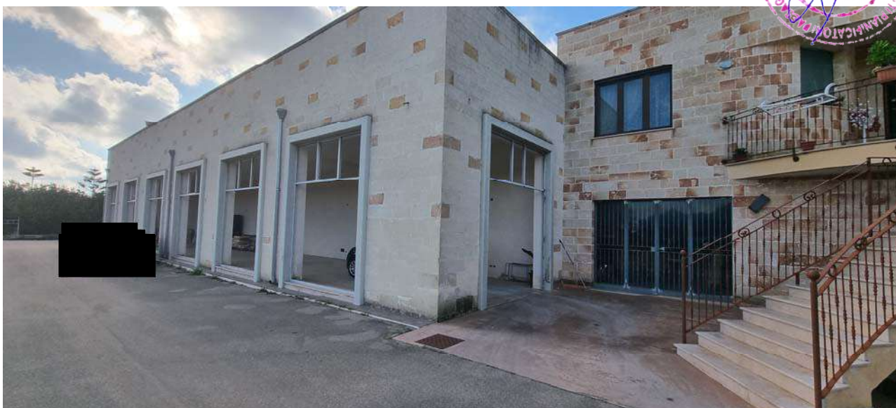
Foto 9: Prospetti NORD-EST della zona in costruzione fascia laterale EST del subalterno 9
