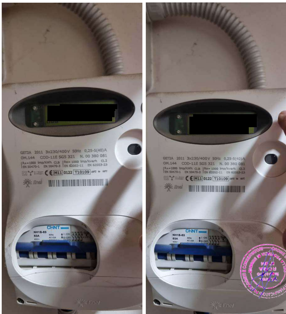
Foto 45 - Foto 46: Contatori ENEL per lo scambio sul posto con lettura della data di visualizzazione
