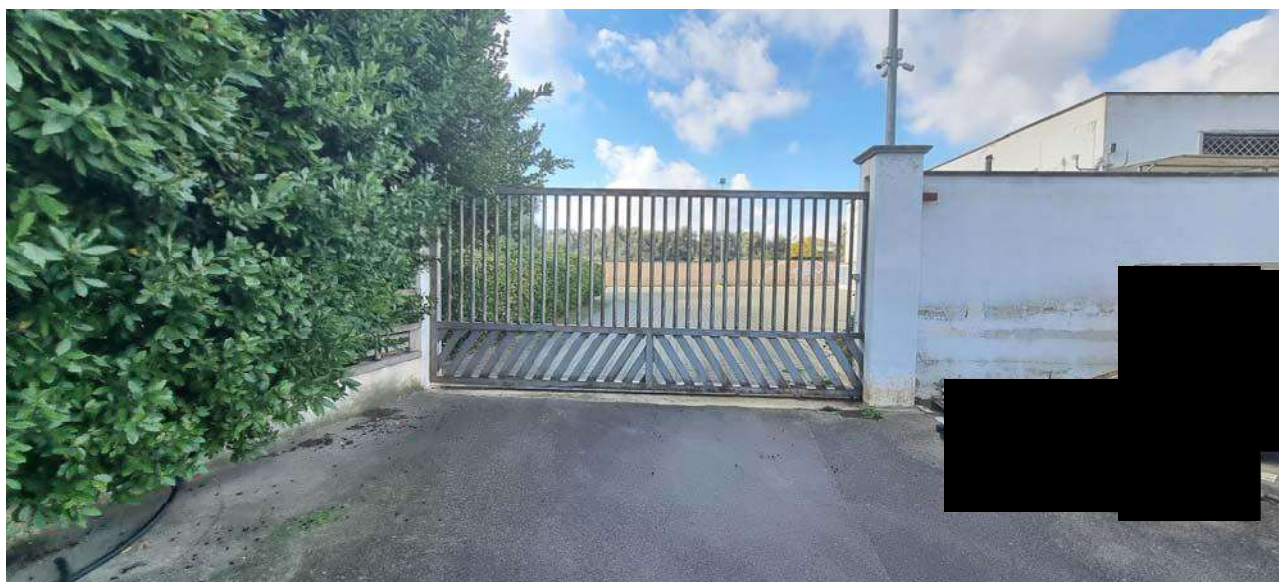
Foto 14: Cannello in angolo SUD-OVEST di collegamento tra le particelle 150 oggetto di perizia e P.Ila 282.
