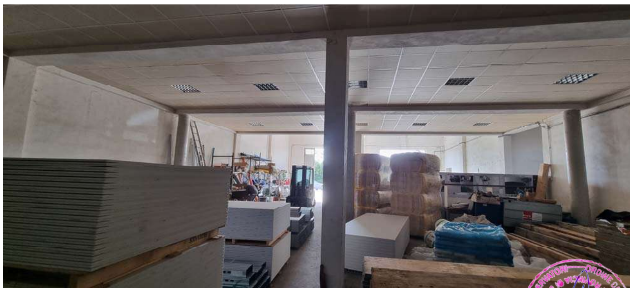
Foto 25: Interno del capannone interno 3
