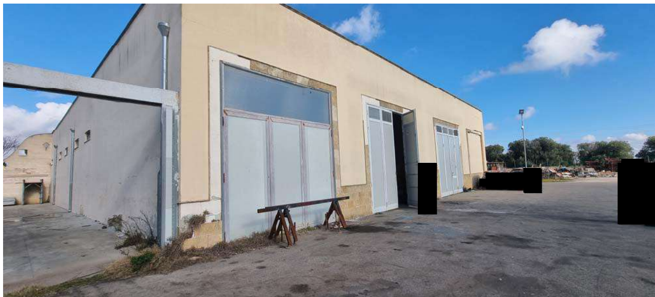
Foto 13: Particolare della stessa vista, con chiusura della porzione laterale ad OVEST del piazzale
