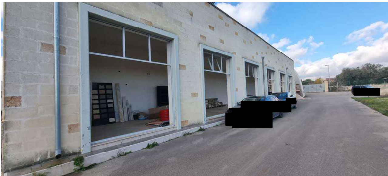
Foto 10: Vista del fronte EST del subalterno 9 – zona in costruzione
