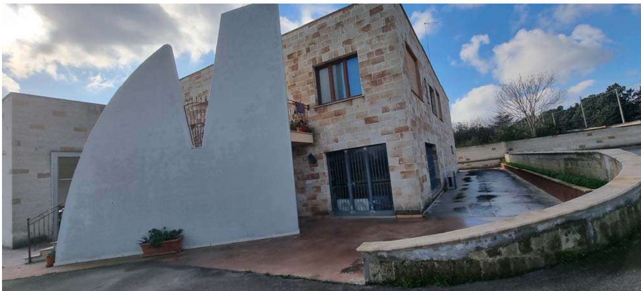
Foto 7: Scala di accesso al 1° piano
