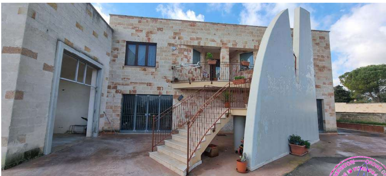
Foto 8: Altra vista alla Scala di accesso al 1° piano – Accesso NORD del subalterno 9
