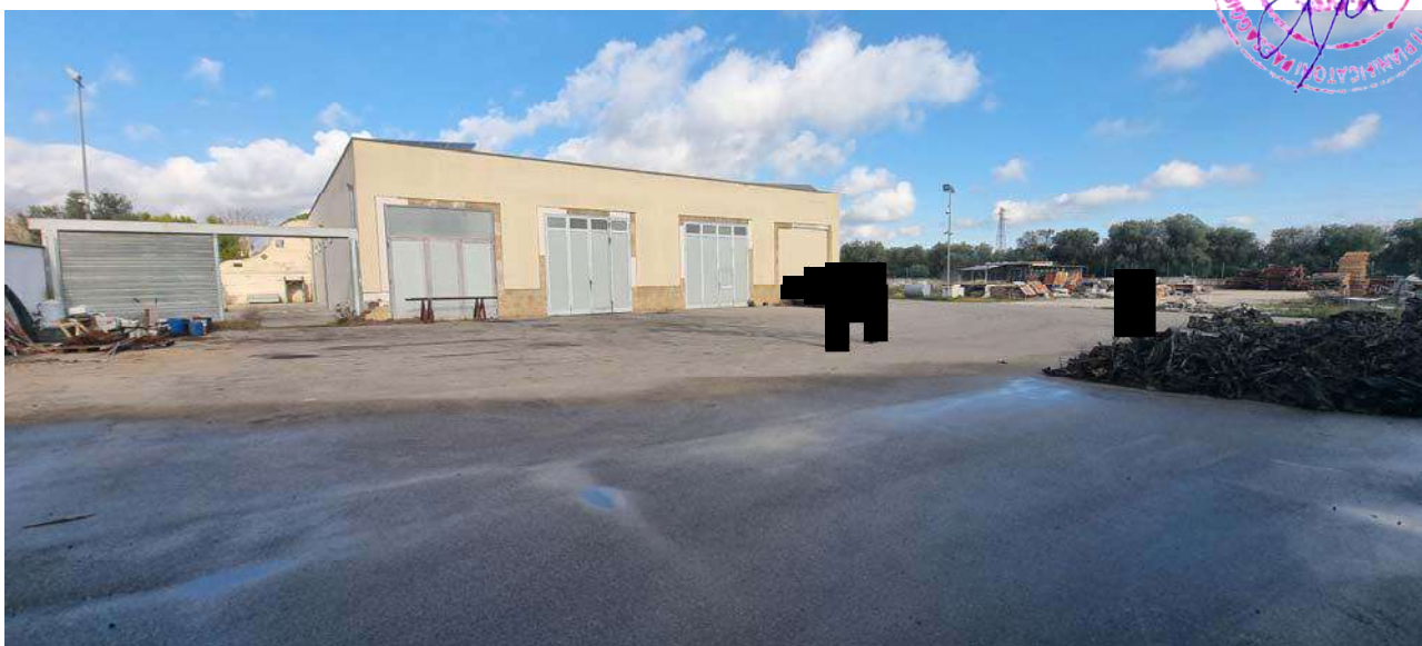
Foto 12: Vista complessiva del fronte SUD con vista generale della relativa zona di piazzale antistante.
