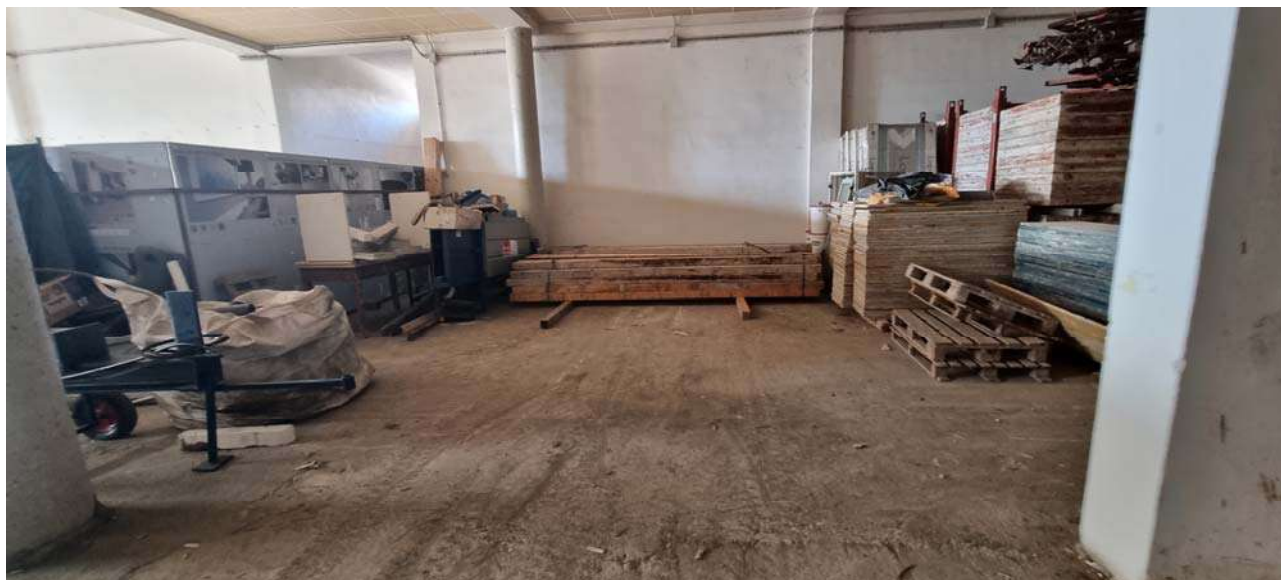
Foto 27: Interno del capannone sub 3 con vista sullo sfondo del varco di collegamento con il subalterno 9
