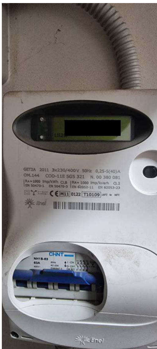
Foto 43 - Foto 44: Contatori ENEL per lo scambio sul posto con lettura della data di visualizzazione
