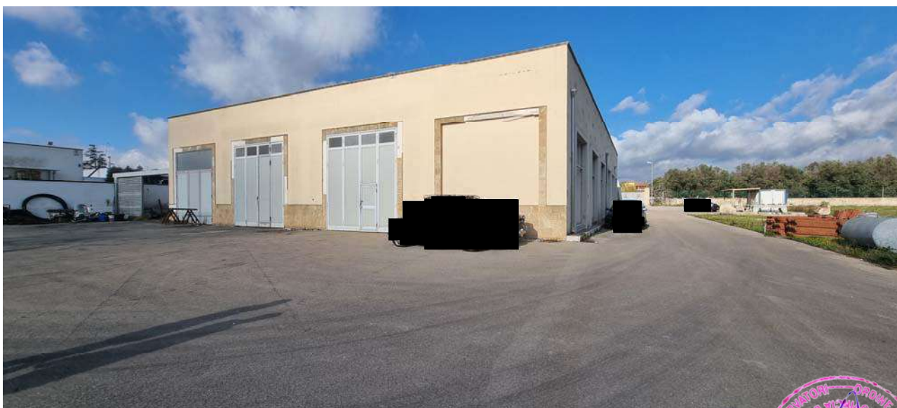
Foto 11: Vista del fronte SUD del subalterno 9
