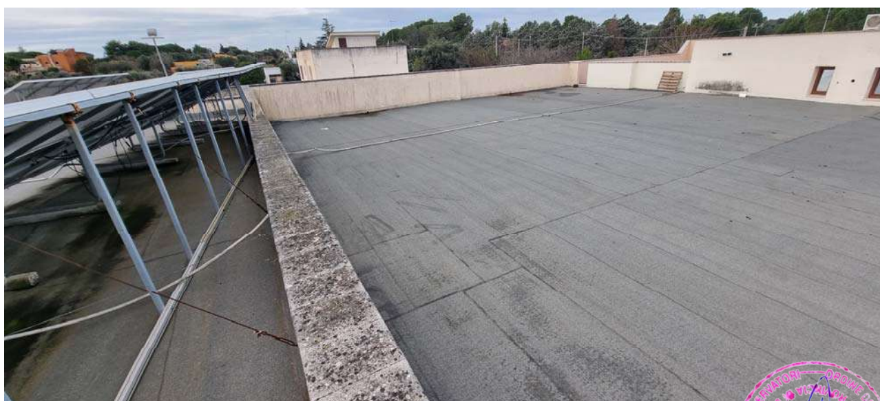
Foto 41: Particolare della terrazza di copertura
