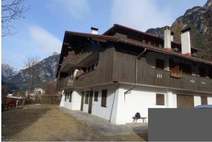
Vista fabbricato da sud-est
