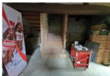
FOTO N°3: scale collegamento tra piano terra e piano primo
