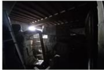
FOTO N°5: veduta porzione del piano primo, parete sud
