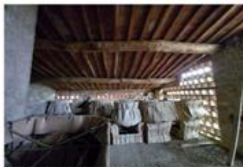
FOTO N°7: veduta porzione del piano secondo, parete nord
