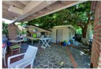
FOTO N°10: veduta del ripostiglio esterno e parte del portico, area pavimentata
