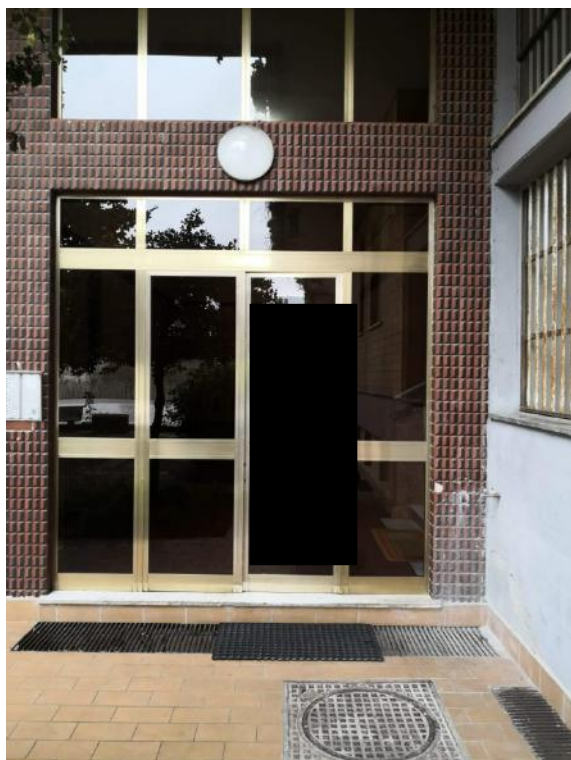
Foto 3) Ingresso al fabbricato
