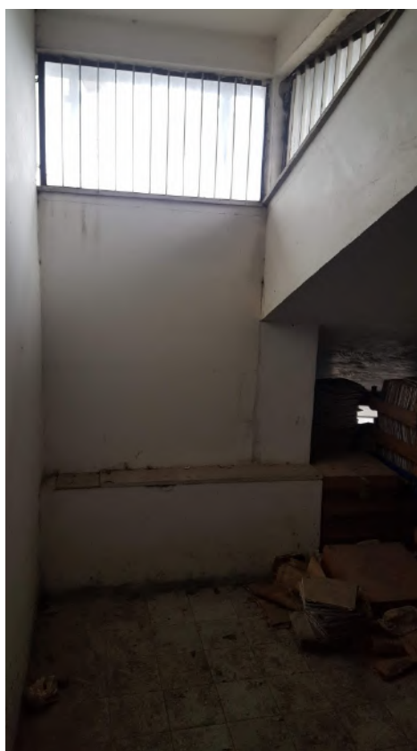
Foto 8) Finestrone versante Nord
