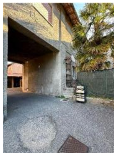
Vista fronti ovest e sud da corte comune
