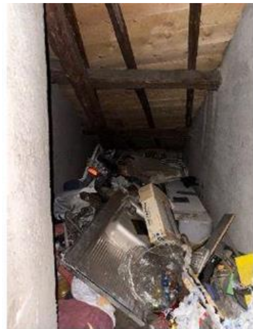
Ripostiglio sottotetto (P4)
