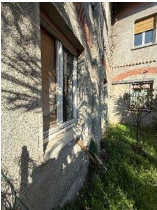
Vista fronte sud
