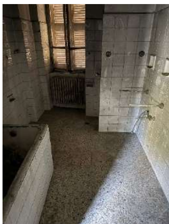
Foto 17 – Interno – Bagno (PT)
