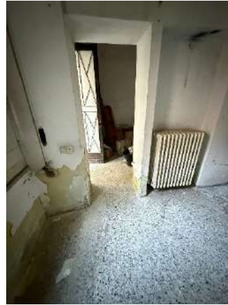
Foto 10 – Interno – Primo locale ex camera
