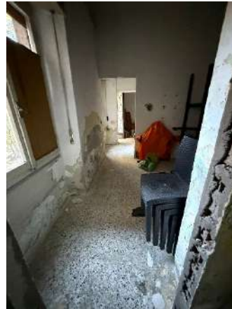
Foto 12 – Interno – Secondo locale ex camera
