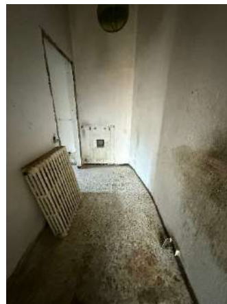
Foto 14 – Interno – Cucinino (PT)
