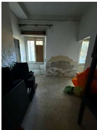
Foto 13 – Interno – Secondo locale ex camera (PT)
