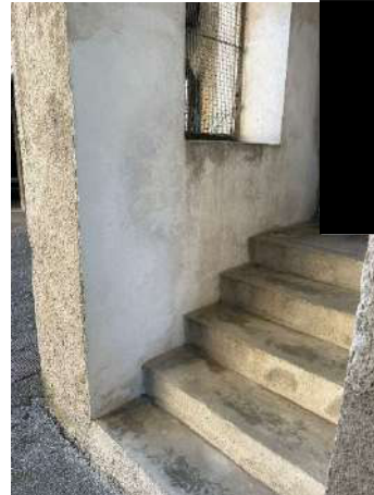
Foto 6 – Esterno – Scala ingresso passaggio coperto
