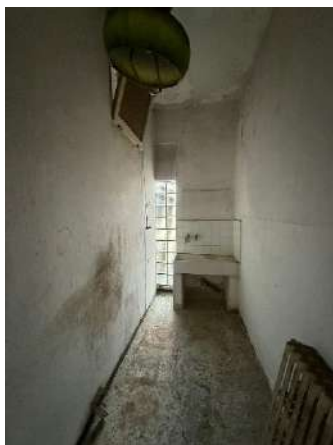
Foto 15 – Interno – Cucinino (PT)
