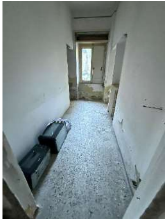
Foto 11 – Interno – Primo locale ex camera
