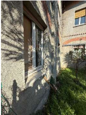
Foto 5 – Esterno – Fronte sub
