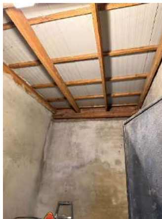
Foto 20 – Interno – Ripostiglio (P4)
