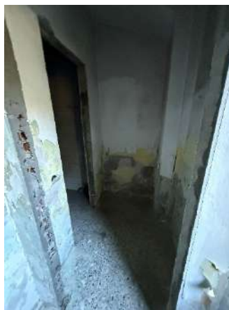
Foto 16 – Esterno – Antibagno (PT)
