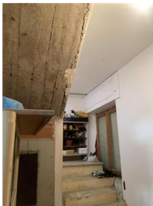
Scala condominiale interna
