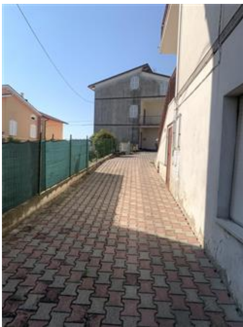
Rampa accesso Piano seminterrato Lato Est
