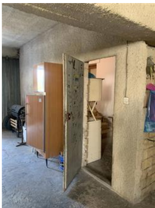
Locale seminterrato - accesso scala condominiale
