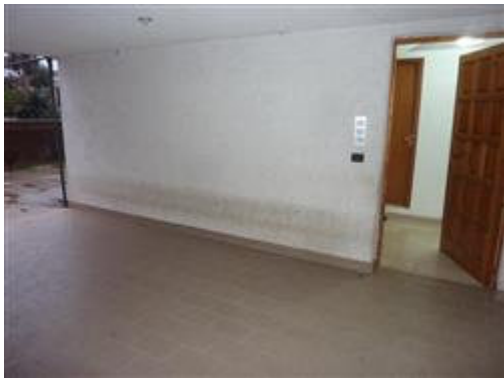
Ingresso al vano scala dal portico comune.
