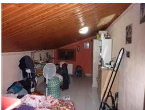
Vano sottotetto - Piano terzo.
