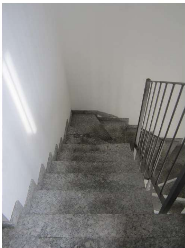
vano scala comune
