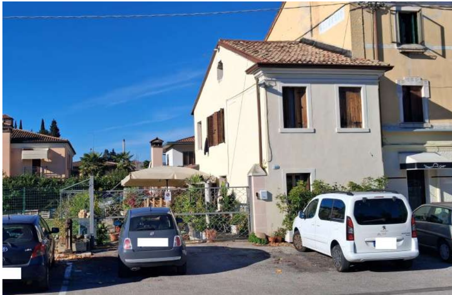
Figura 1 - accesso pedonale e carraio da via Prato Santa Caterina n.10
