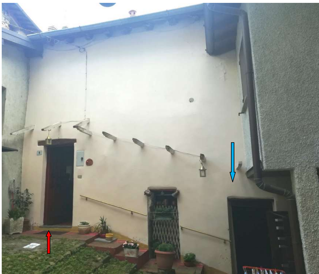
la freccia rossa indica l'ingresso all'immobile pignorato, quella azzurra alla cantina
