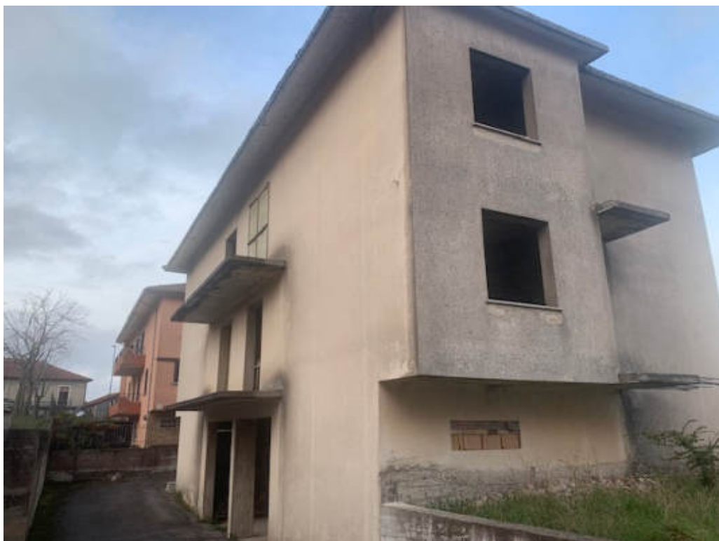
FOTO ESTERNI FRONTE SUD-OVEST
