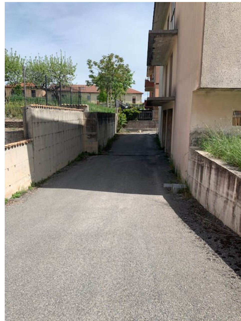
FOTO ESTERNI RAMPA DI ACCESSO AL SEMINTERRATO
