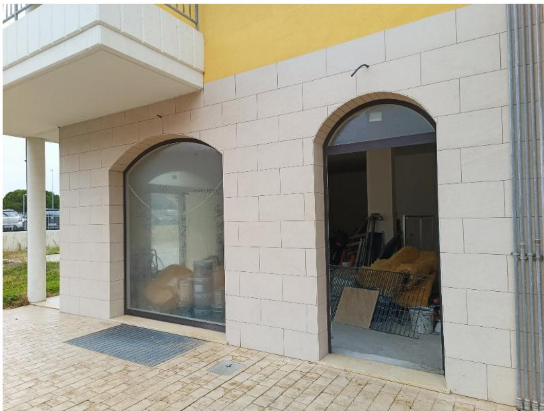
Foto 1: Ingresso locale commerciale con porzione di area pavimentata con cemento stampato
