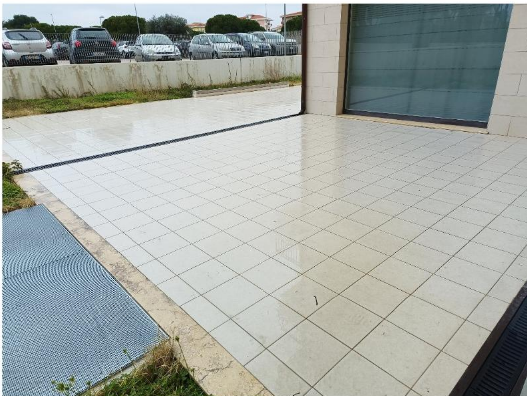
Foto 8: Vista lastrico solare
