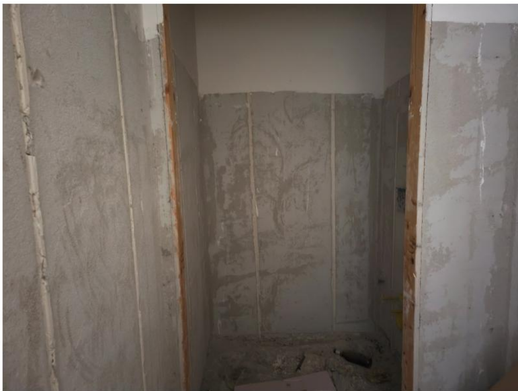
Foto 4: Bagno con antibagno realizzato in diffinità
