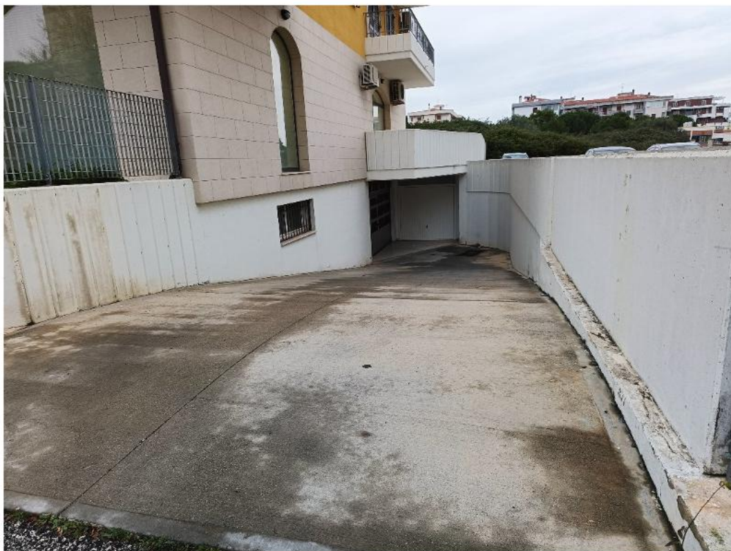
Foto 1: Rampa ingresso garage
