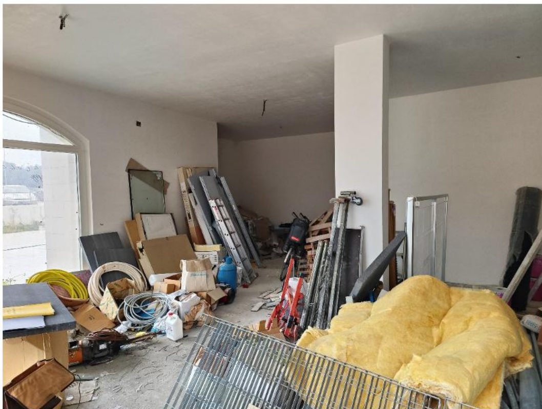
Foto 2: Vista interna locale
