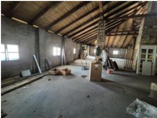
Vista interna vano soffitta - piano terzo
