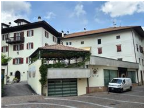
Vista prospetto sud intero edificio, dove sono presenti gli immobili oggetto di valutazione nel Lotto 2
