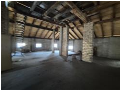
Vista interna vano soffitta - piano terzo
