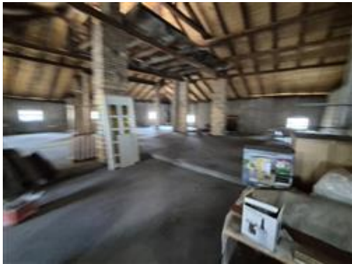
Vista interna vano soffitta - piano terzo
