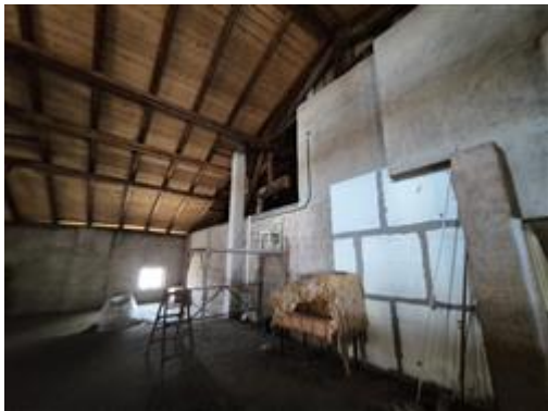
Vista posizione vano soffitta - piano quarto
