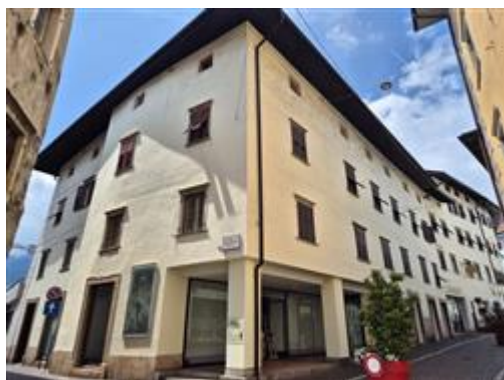
Vista prospetti nord e est intero edificio, dove sono presenti gli immobili oggetto di valutazione nel Lotto 2
