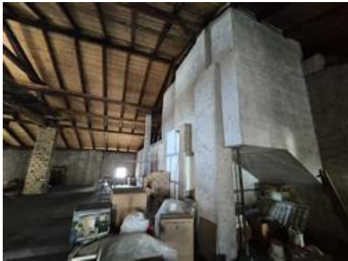
Vista interna vano soffitta - piano terzo
