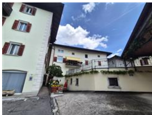
Vista prospetto sud intero edificio, dove sono presenti gli immobili oggetto di valutazione nel Lotto 1
