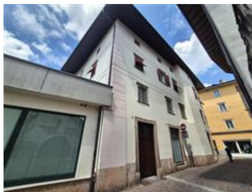
Vista prospetto est intero edificio, dove sono presenti gli immobili oggetto di valutazione nel Lotto 2
