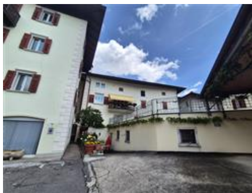
Vista prospetto sud intero edificio, dove sono presenti gli immobili oggetto di valutazione nel Lotto 1
