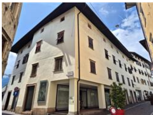
Vista prospetti nord e est intero edificio, dove sono presenti gli immobili oggetto di valutazione nel Lotto 1
