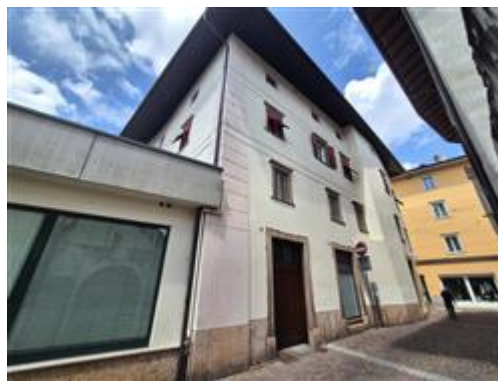
Vista prospetto est intero edificio, dove sono presenti gli immobili oggetto di valutazione nel Lotto 1
