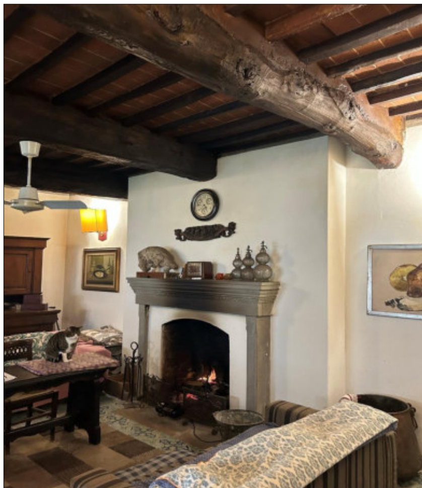
Foto 5 – particolare caminetto e solaio in legno
