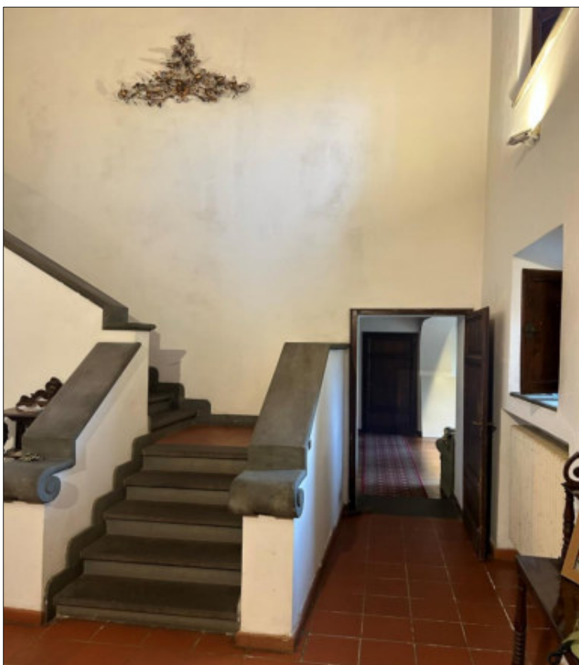
Foto 8 – corpo scala principale
