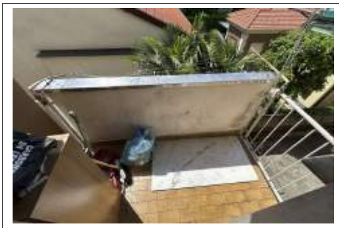
11. BALCONE 1 CON ACCESSO DALLA CUCINA
