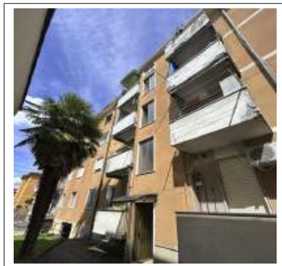
2. L'IMMOBILE DALL'INGRESSO SUL RETRO-CORTILE
