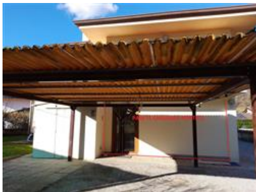
Parete realizzata a chiusura del portico
