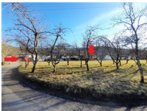
Fabbricato visto dal bivio di accesso
