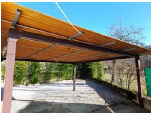
vista laterale della tettoia
