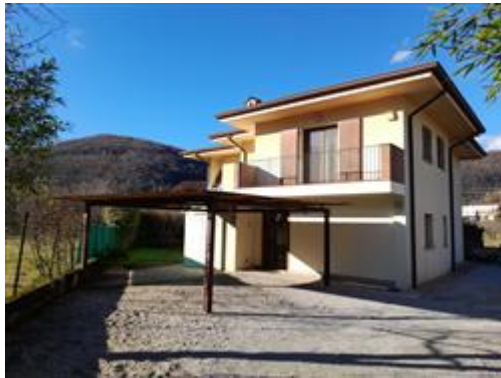
Facciata posteriore con tettoia abusiva e corte pavimentata
