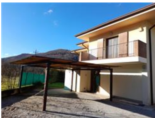
vista frontale della tettoia dalla quale si rileva la distanza dal confine
