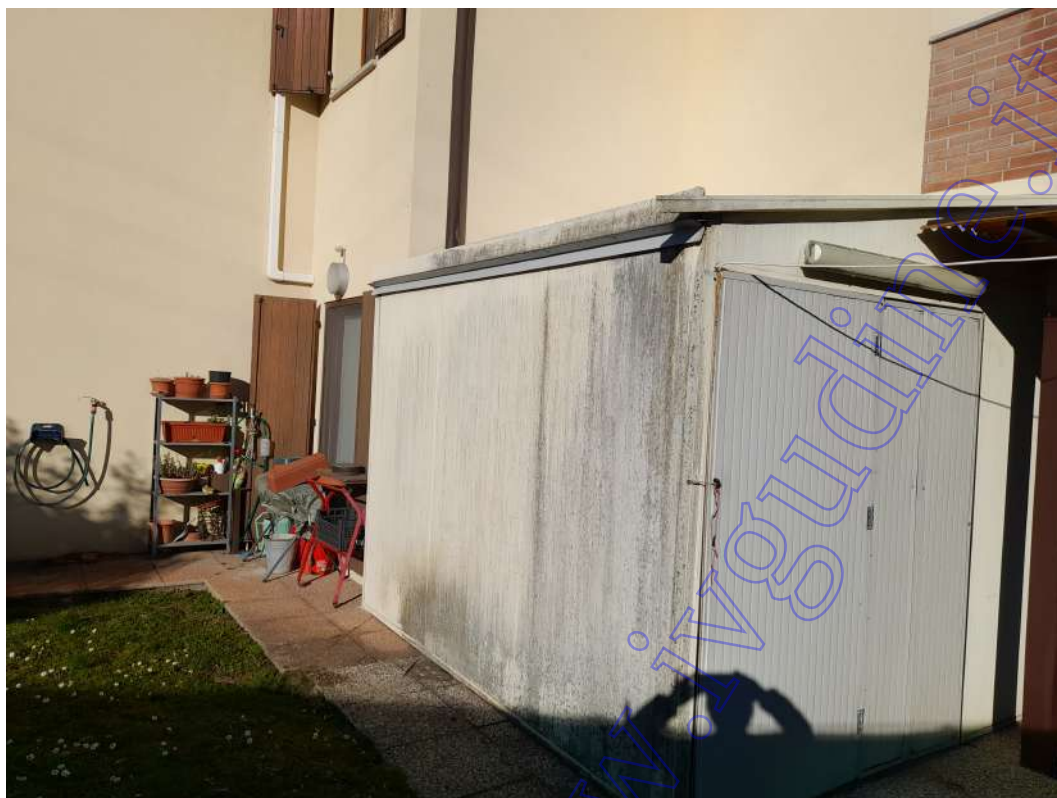
deposito attrezzi abusivo
