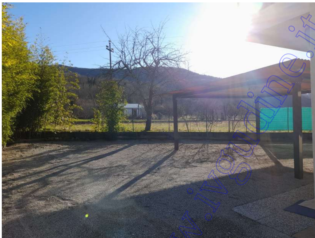
corte posteriore con tettoia abusiva
