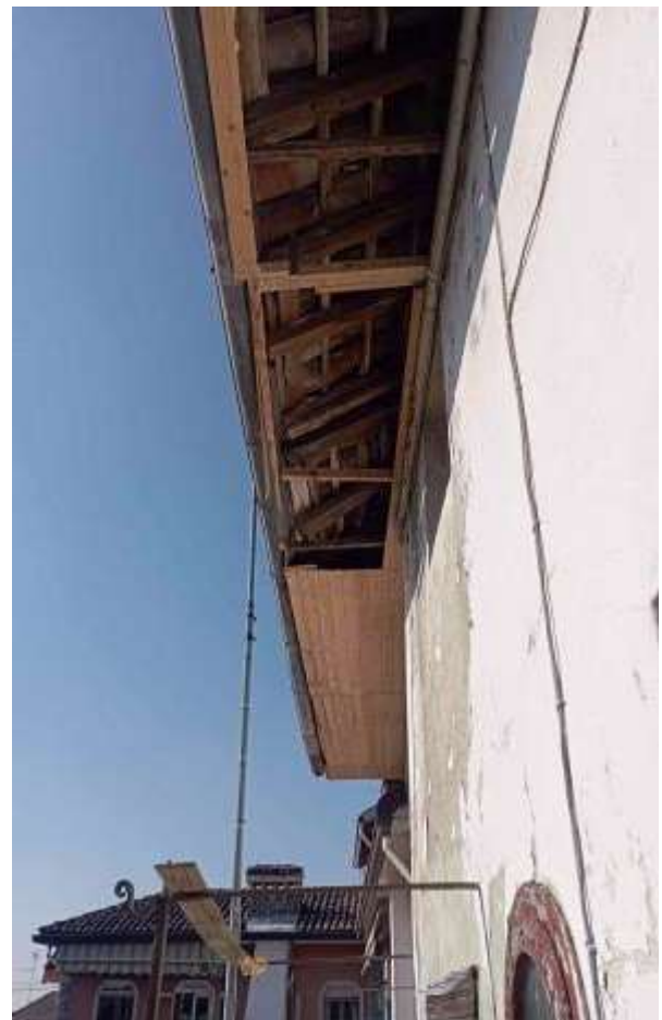
Particolare situazione copertura
