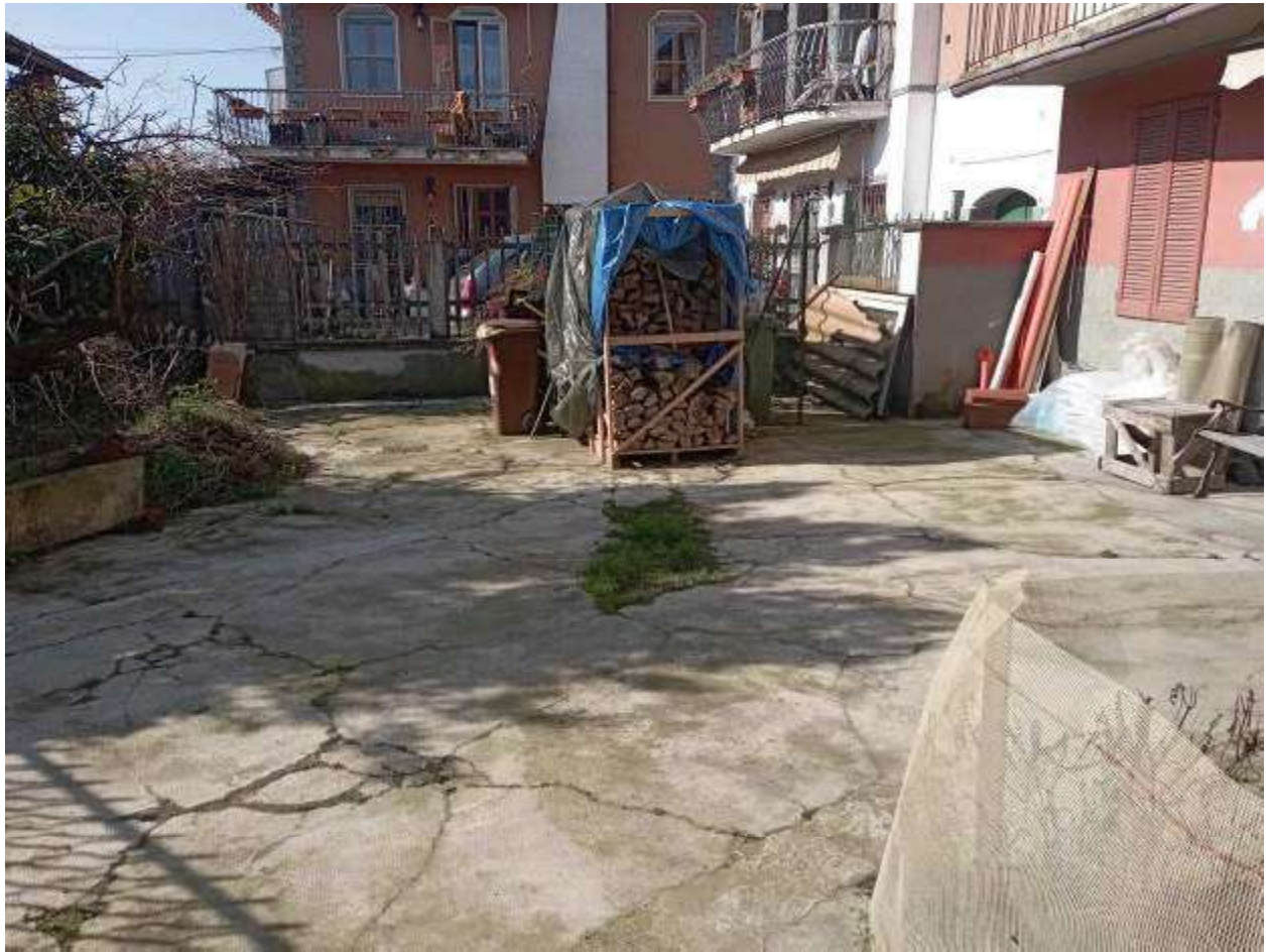
Cortile comune lato Sud
