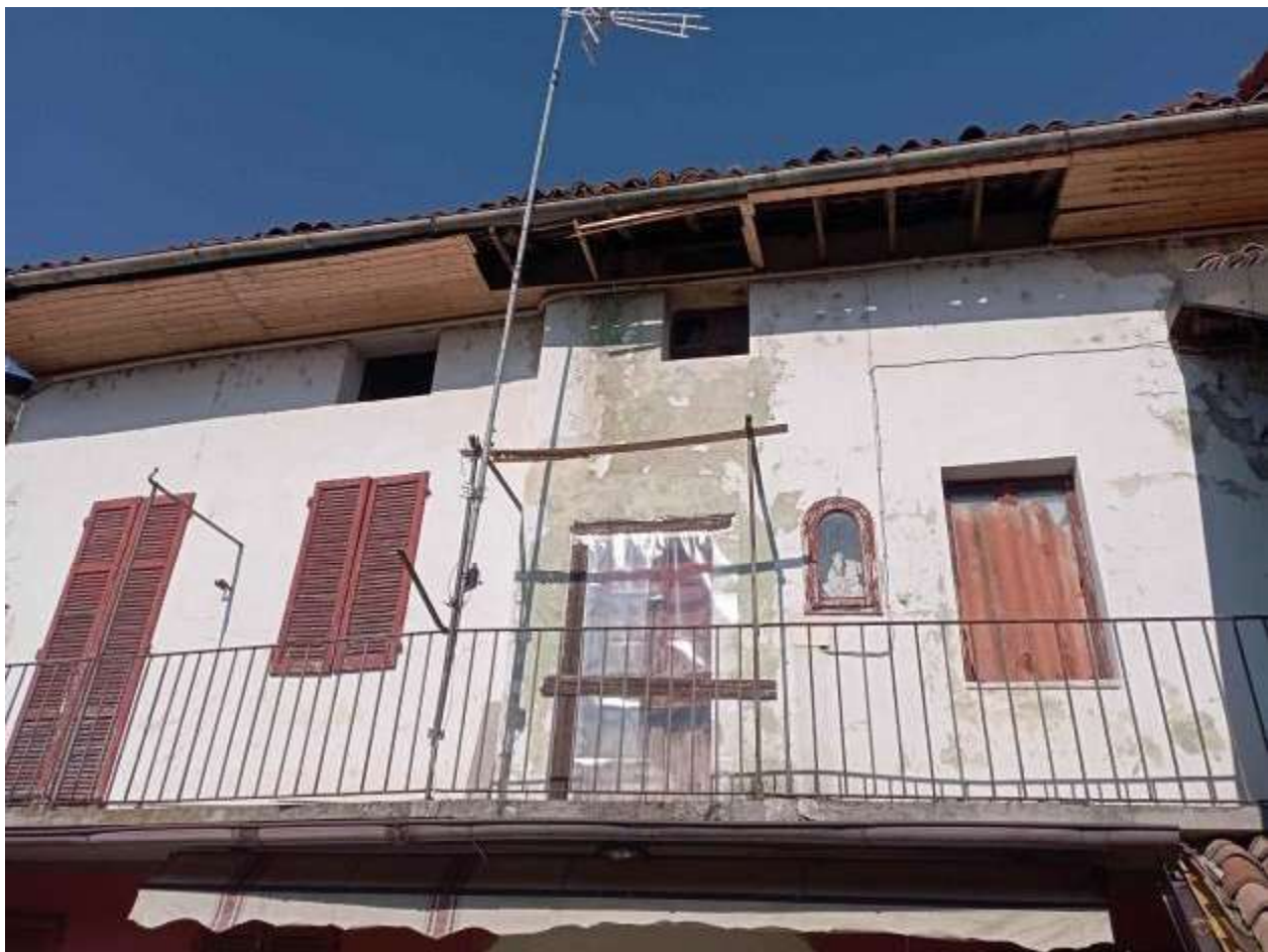
Prospetto principale su cortile comune lato Sud
