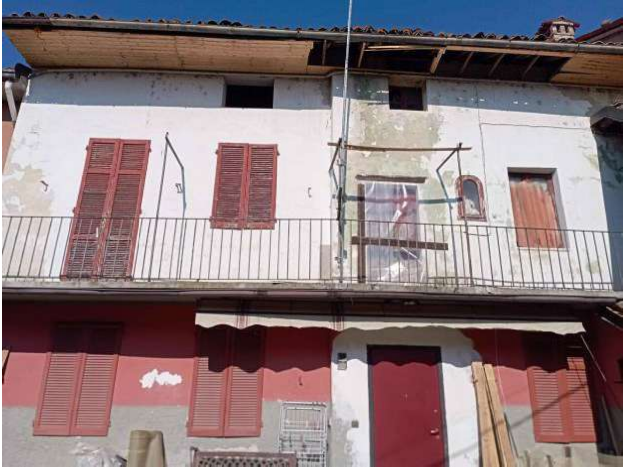
Prospetto principale su cortile comune lato Sud
