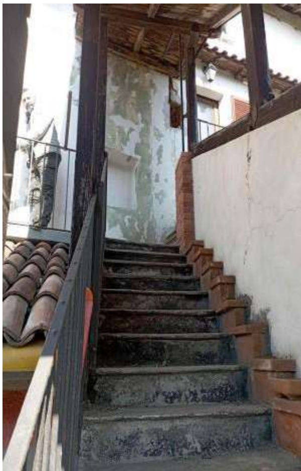
Tampa di accesso al poggiolo 1P
