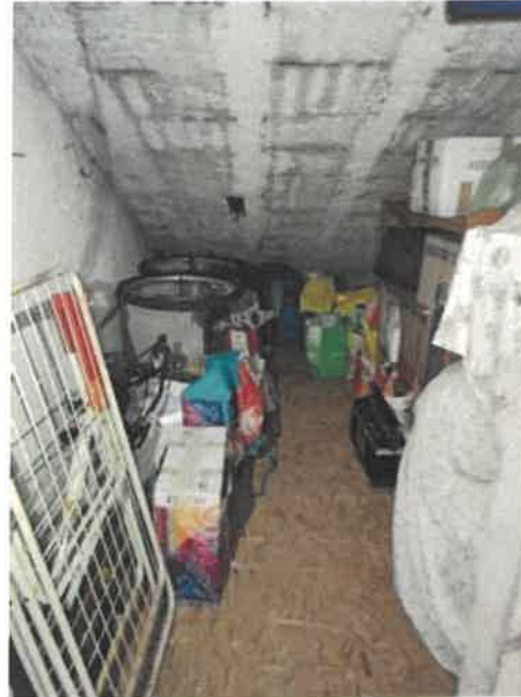
Vista ripostiglio /sottotetto
