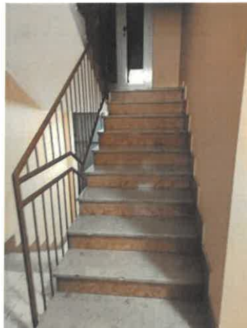
particolare vano scala comune
