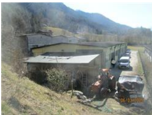
VISTA EDIFICIO LATO NORD - IN PRIMO PIANO IL MANUFATTO AGGIUNTO PREVISTO IN DEMOLIZIONE
