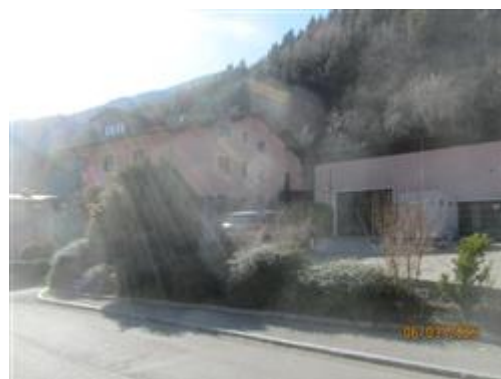
VISTA ESTERNA EDIFICIO - IL BENE IN OGGETTO SI
