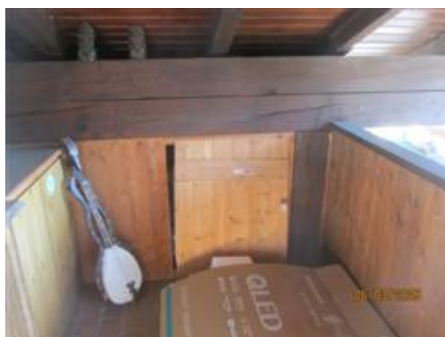
RIPOSTIGLIO ESTERNO. ACCESSO DA POGGIOLO/BALCONE
