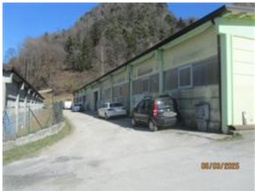
VISTA EDIFICIO LATO SUD-OVEST
