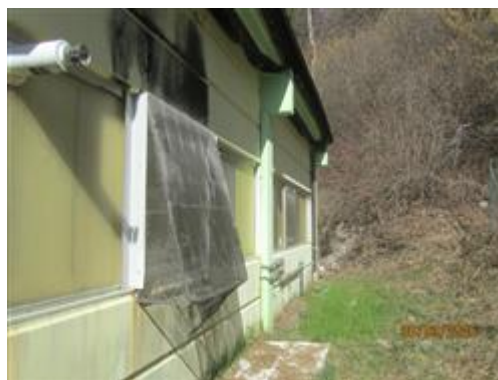
VISTA EDIFICIO LATO EST
