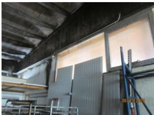
DEPOSITO AGRICOLO IN USO COME DEPOSITO PANIFICIO
