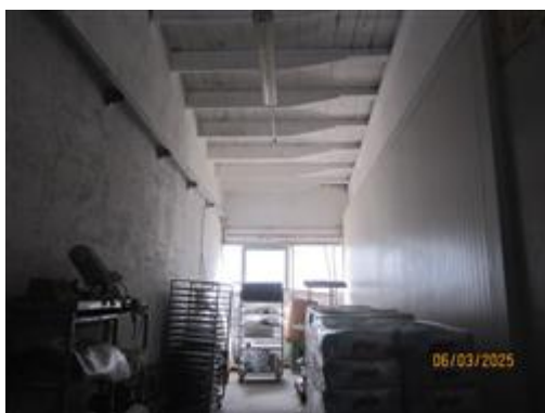
MAGAZZINO MATERIE PRIME (PANIFICIO)
