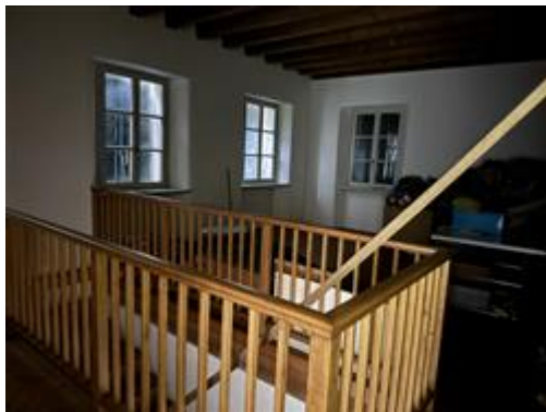
accesso al piano primo
