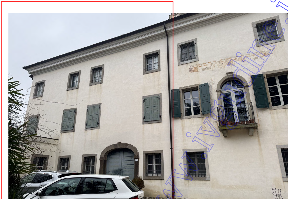
Villa prospetto principale parte pignorata
