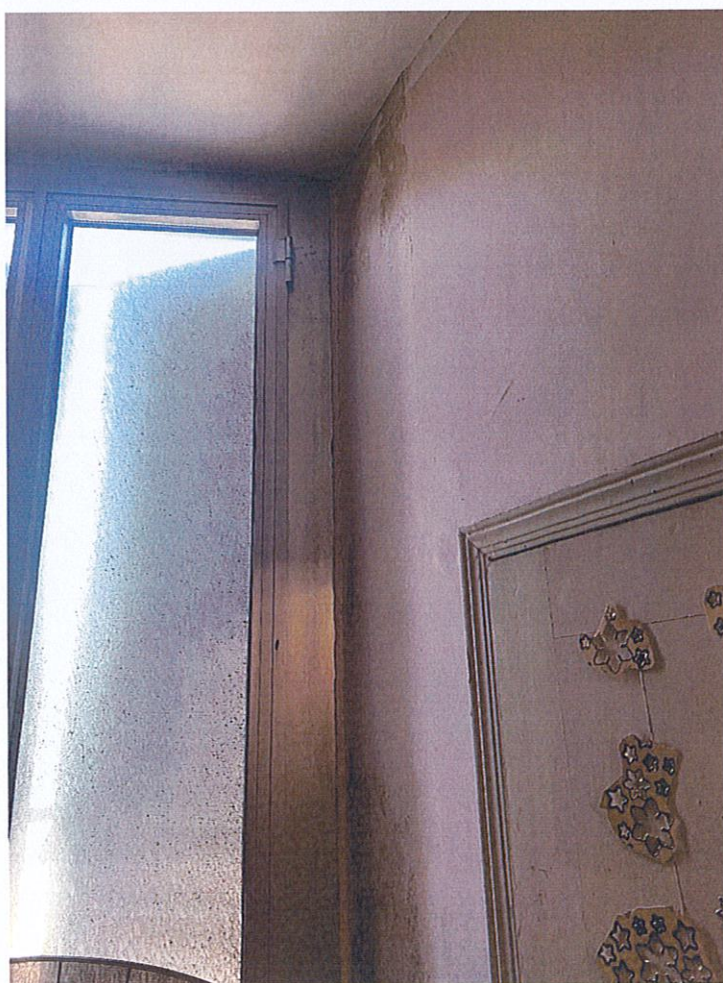
Foto 23. Particolare infiltrazioni
