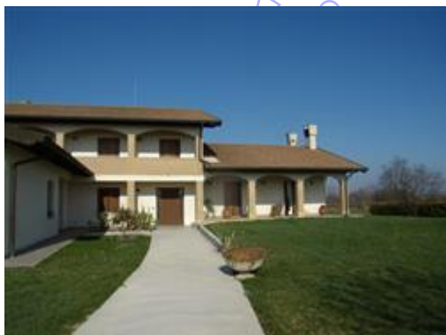
Prospetto sud (parte) con ingresso pedonale principale
