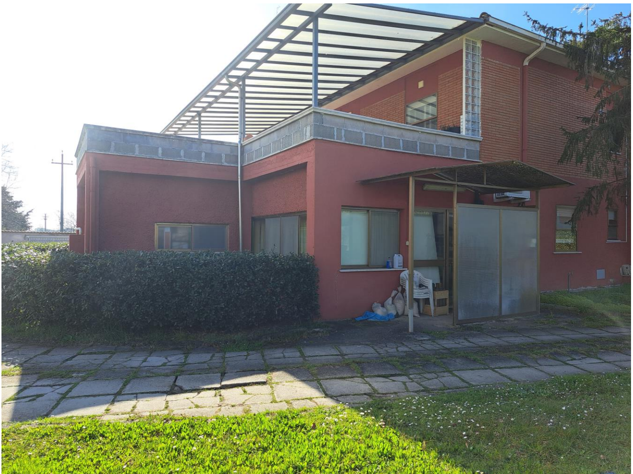
Foto n° 1 – Vista dell'immobile da Nord Ovest – via Nascosa n. 4407 - Latina
