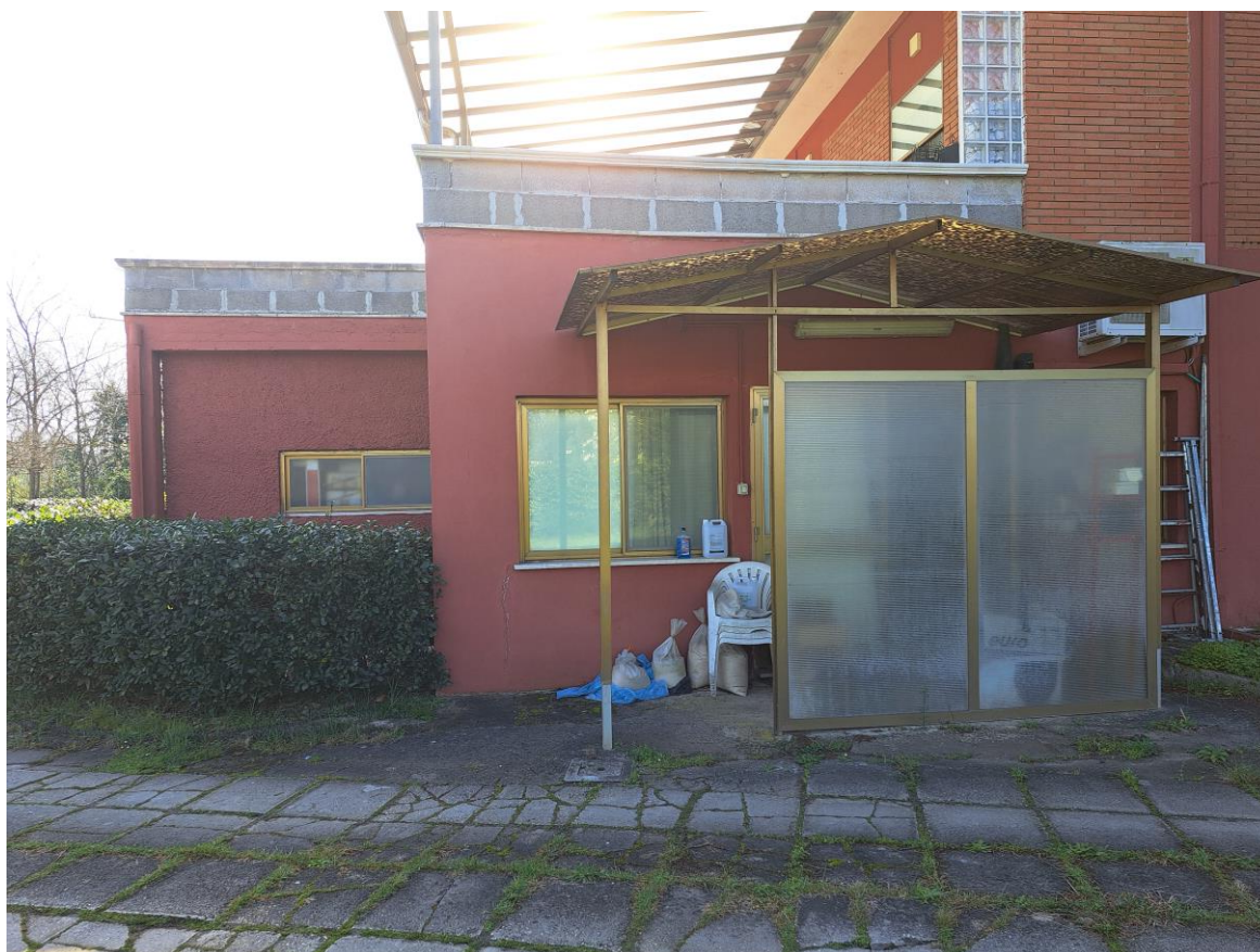
Foto n° 5 – Tettoia con ingresso all'aula – sulla sx arretrato il blocco bagni
