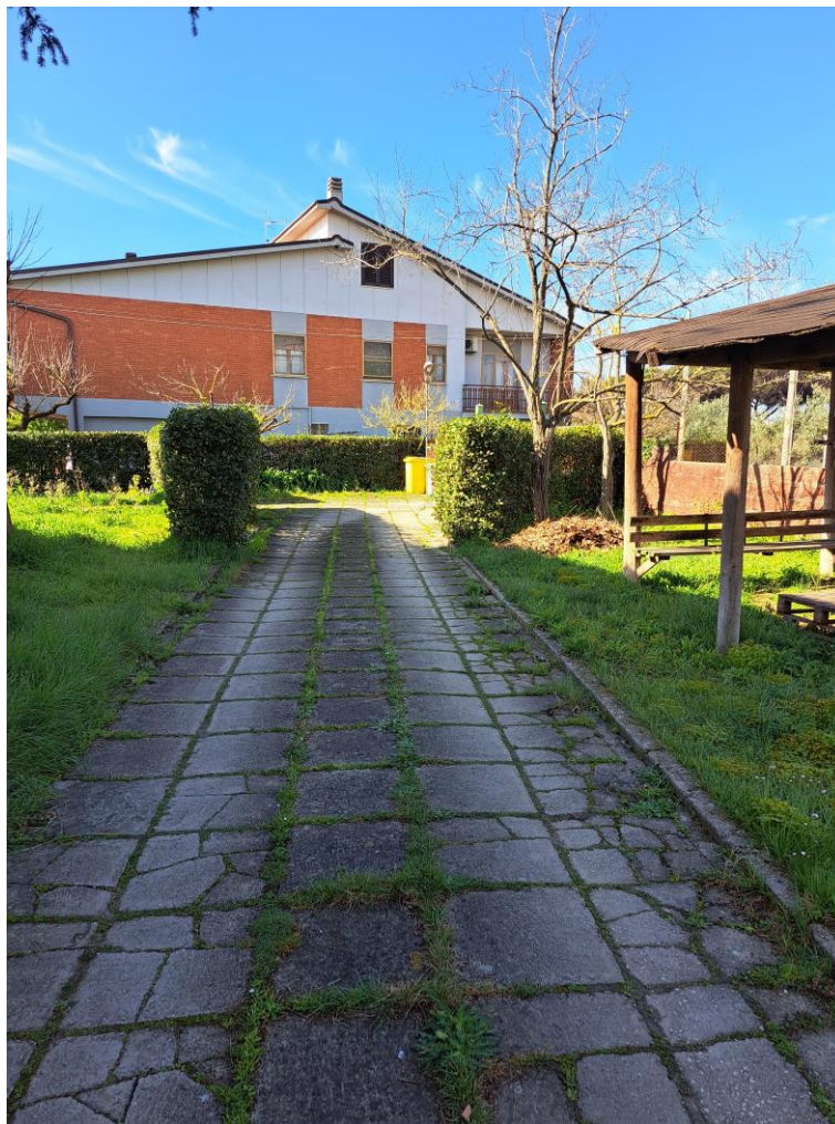
Foto n° 4 – Viale d'ingresso alle proprietà (corte comune con villa unifamiliare)
