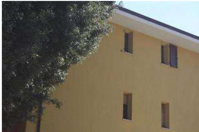
facciata verso Piazza Giuseppe Garibaldi
