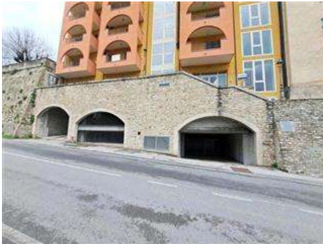
accesso posti auto coperti su via circonvallazione
