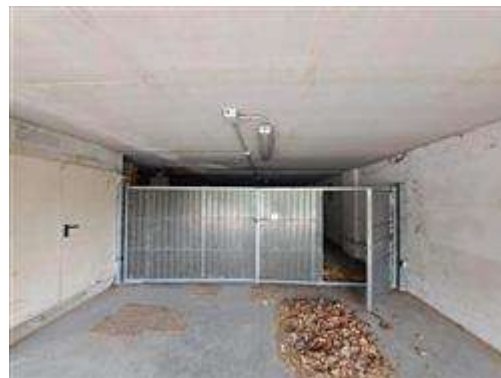
accesso con cancello meccanizzato e con porta pedonale
