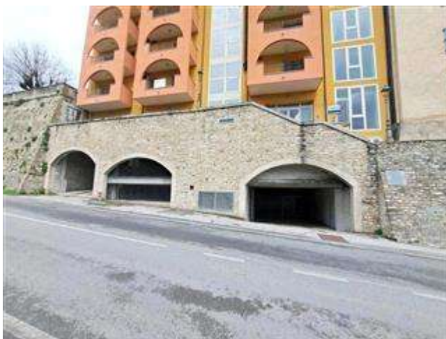
accesso posti auto coperti su via circonvallazione
