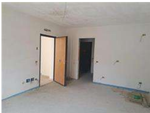
ingresso con portoncino blindato
