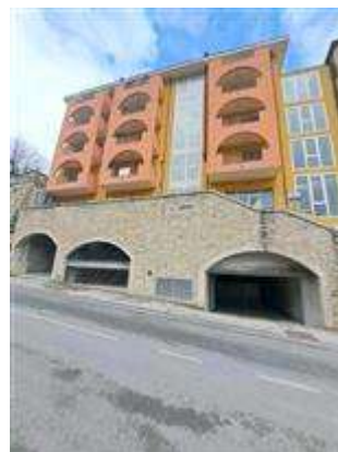
facciata su via Circonvallazione
