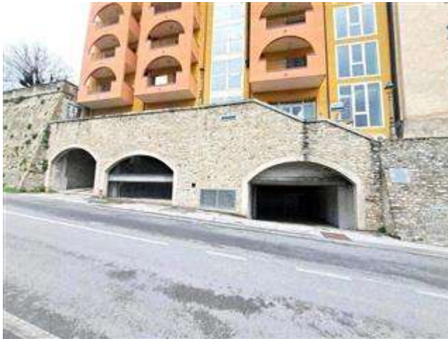
accesso posti auto coperti su via circonvallazione
