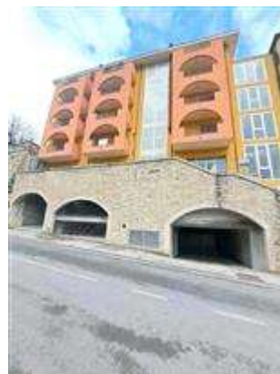
facciata su via Circonvallazione
