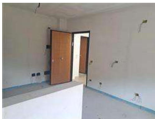
ingresso reparto giorno con portoncino blindato
