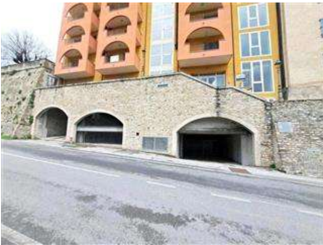
accesso posti auto coperti su via circonvallazione
