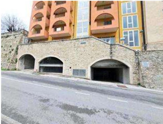
accesso posti auto coperti su via circonvallazione
