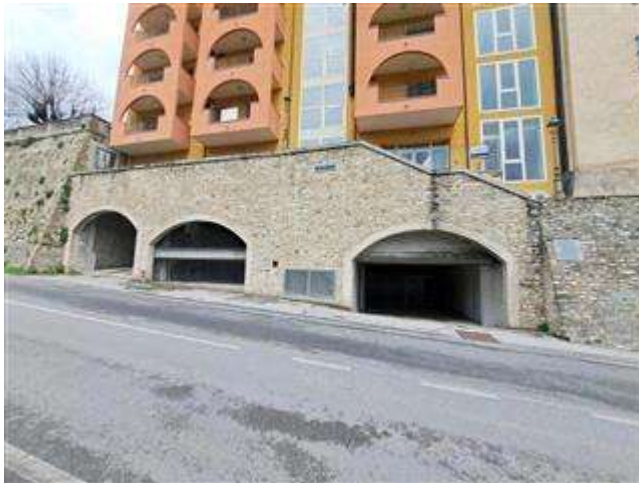
accesso posti auto coperti su via circonvallazione
