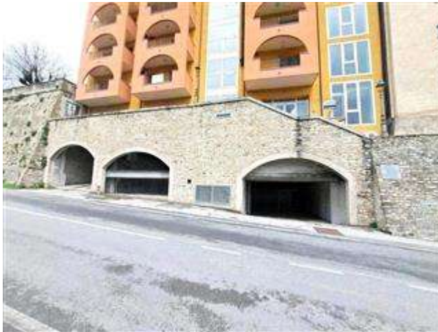
accesso posti auto coperti su via circonvallazione
