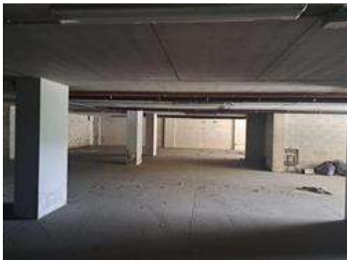
corsello di manovra interna
