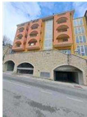
facciata su via Circonvallazione
