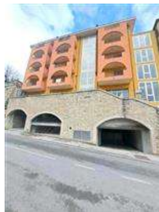
facciata su via Circonvallazione
