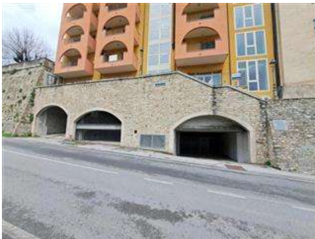
accesso posti auto coperti su via circonvallazione
