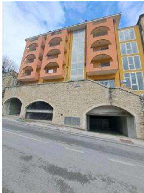
Facciata verso via Circonvallazione con accesso ai Posti Auto Coperti
