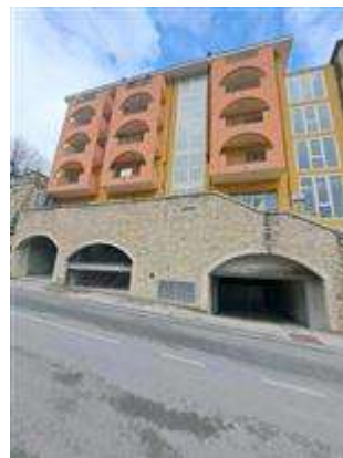
facciata su via Circonvallazione
