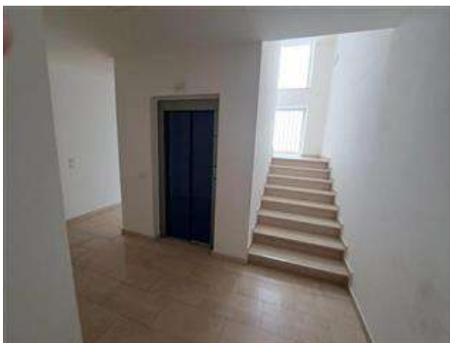
vano scala ed ascensore
