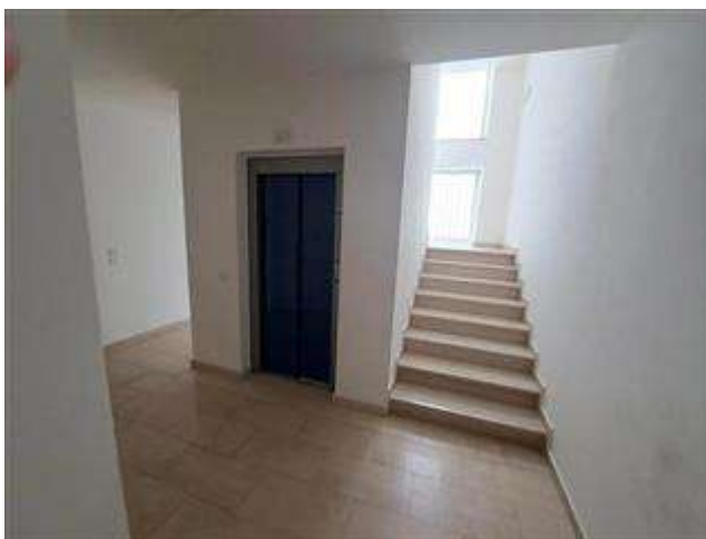
vano scala ed ascensore
